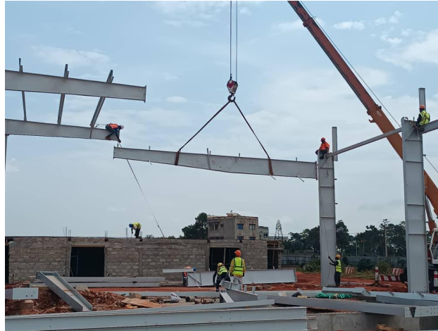
Figure 16: Montage d'une traverse
