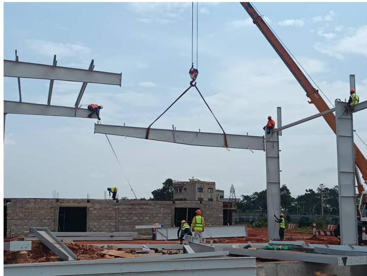
Figure 19 : Montage d'une traverse sur le site
