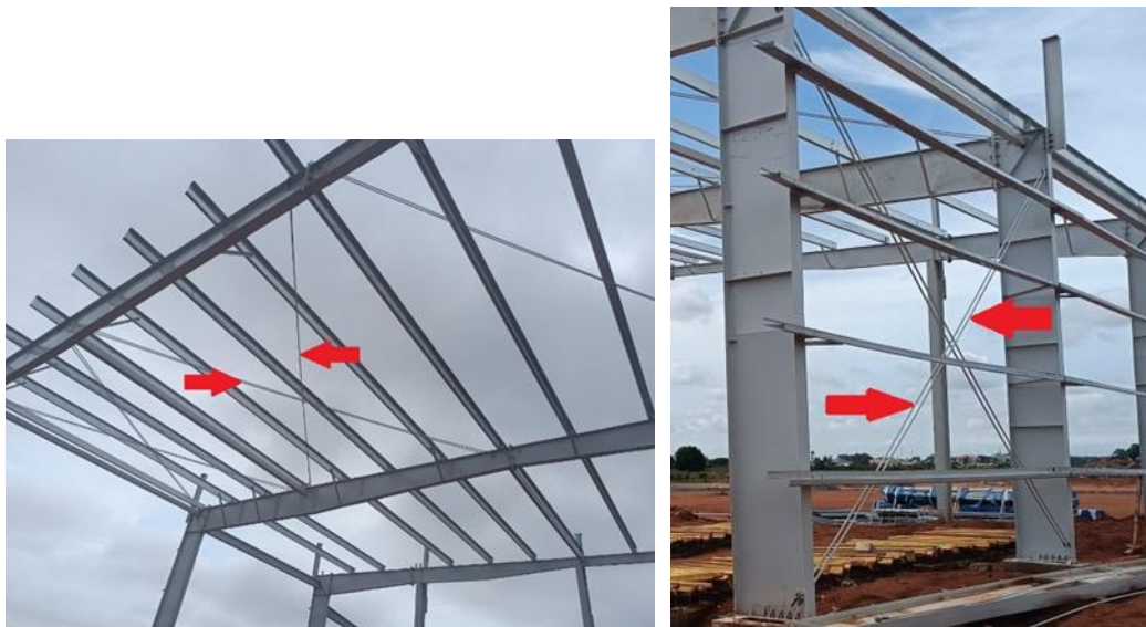
Figure 13 : Aperçu de la poutre au vent (à gauche) et du palet de stabilité (à droite)
