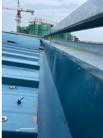
Figure 5 : Aperçu d'un chéneau de toiture [5]
