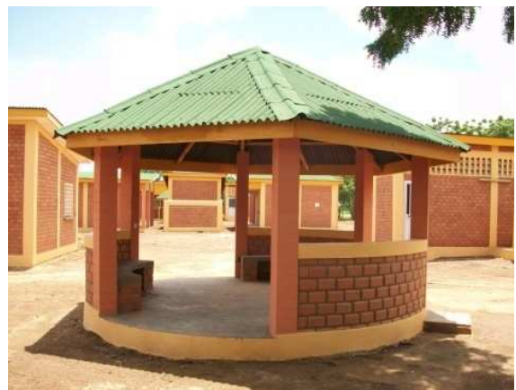
Photo 24 : Toiture des bâtiments
