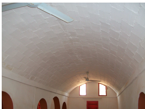
Photo 11 : Toiture en voûte nubienne
