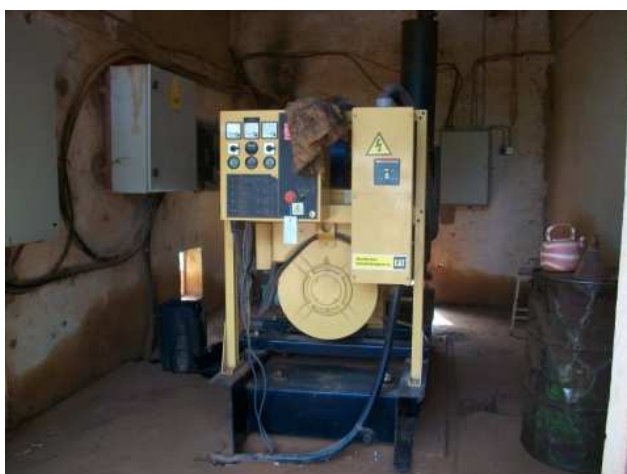
Photo 3 : Groupe électrogène de secours de K1
