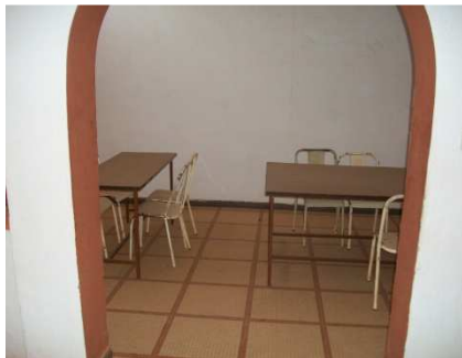
Photo 21 : Plancher du restaurant
