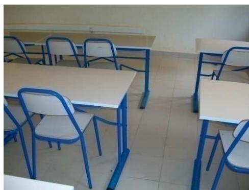
Photo 17 : Plancher revêtu avec des carreaux
