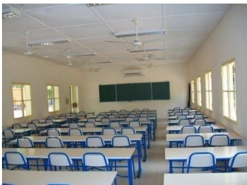
Photo 16 : Mur et faux plafond en couleur blanche
