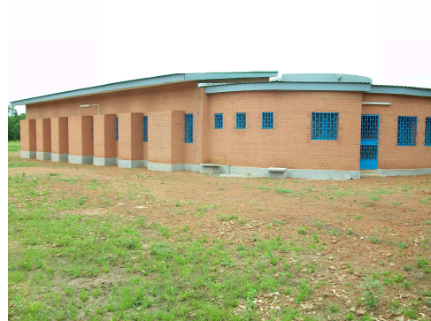
Photo 22 : vue extérieure d'une concession en BTC
