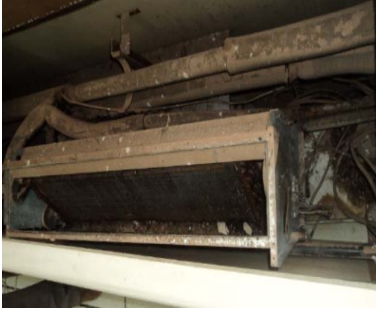
Photo 4 : Ventilateurs convecteurs : Etat délabré
