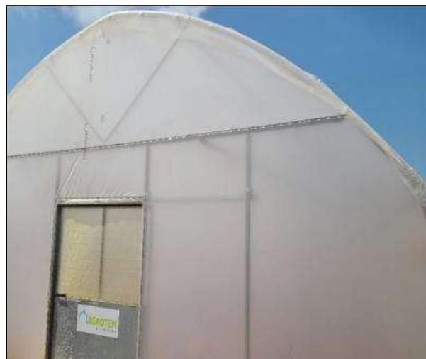
Figure 13: vue extérieure de la serre (source : Lucien KOFFI lors de la visite chantier)
