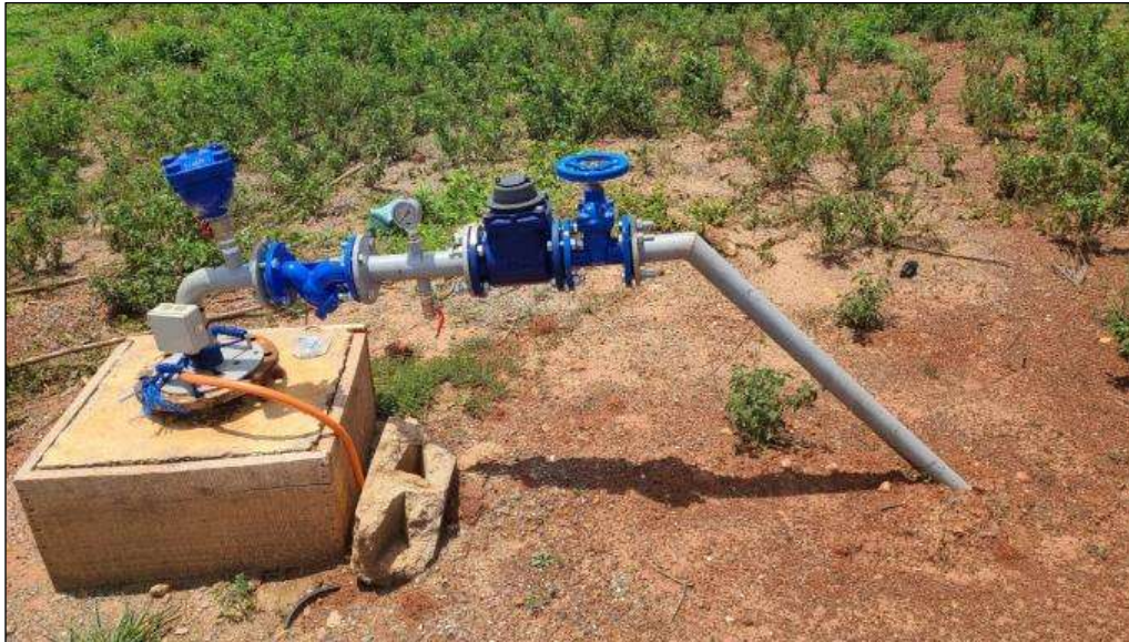
Figure 12: forage équipé (source : Lucien KOFFI lors de la visite chantier)
