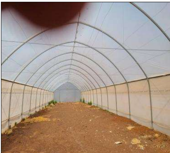
Figure 14: vue intérieure de la serre (source : Lucien KOFFI lors de la visite chantier)
