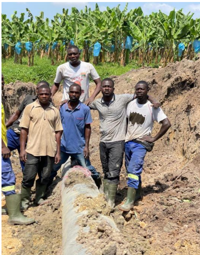
Travaux de réparation de conduite PVC 400mm
