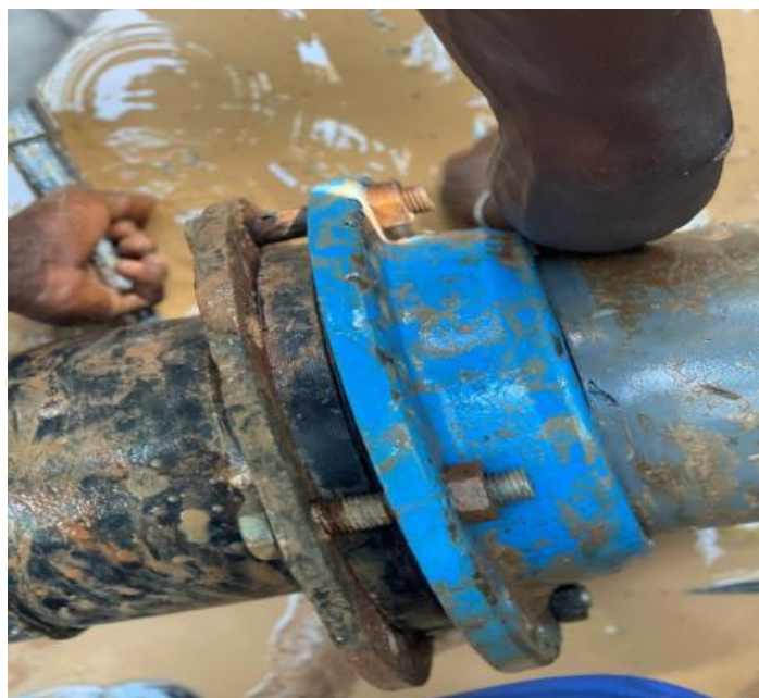
Réparation de conduite DN 200mm
