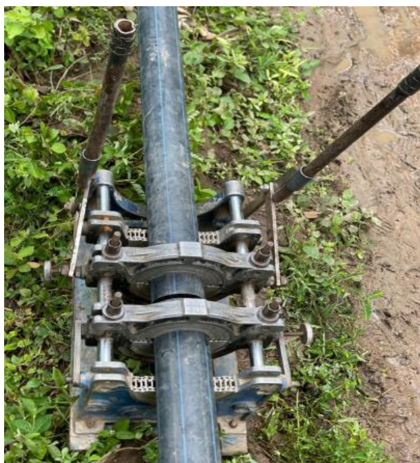
Soudure d'un PEHD 110mm
