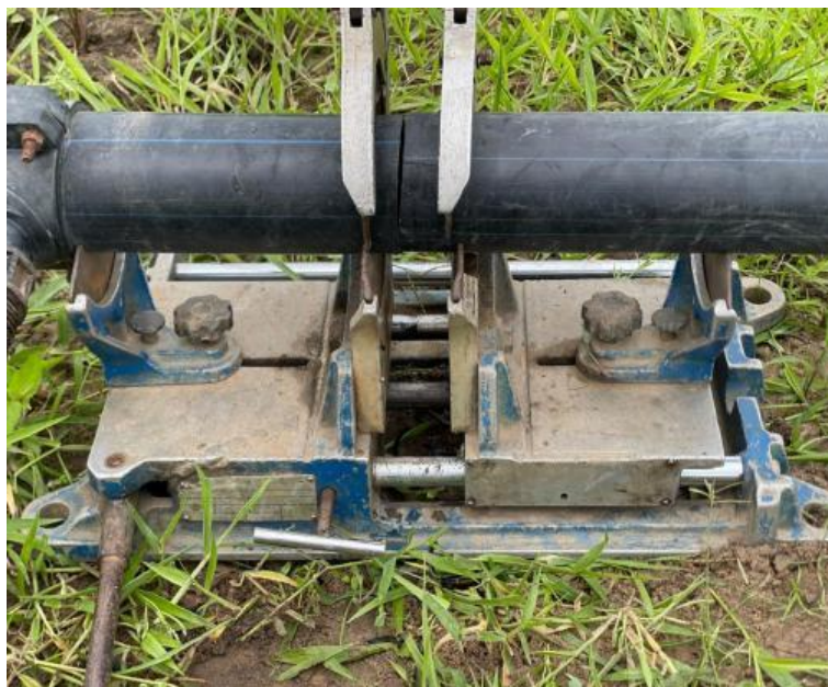
soudure de PEHD 110mm
