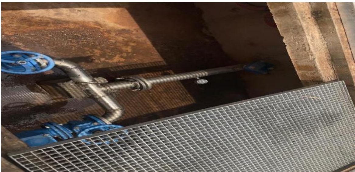
Figure 15 : Conduite de refoulement (Auteur : Sanogo Aboubakar)
