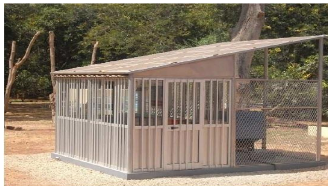
Figure 13: central solaire hybride PV/GE sans stockage (Kamboinsé-Burkina Faso)
