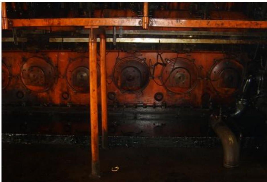
Figure 21: dépôt d'huile et de combustibles au niveau du G6
