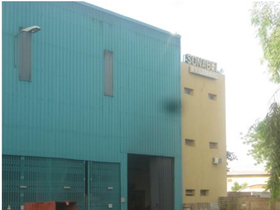
Figure 3 : Façade principale de la centrale abritant les groupes 1 à 6
