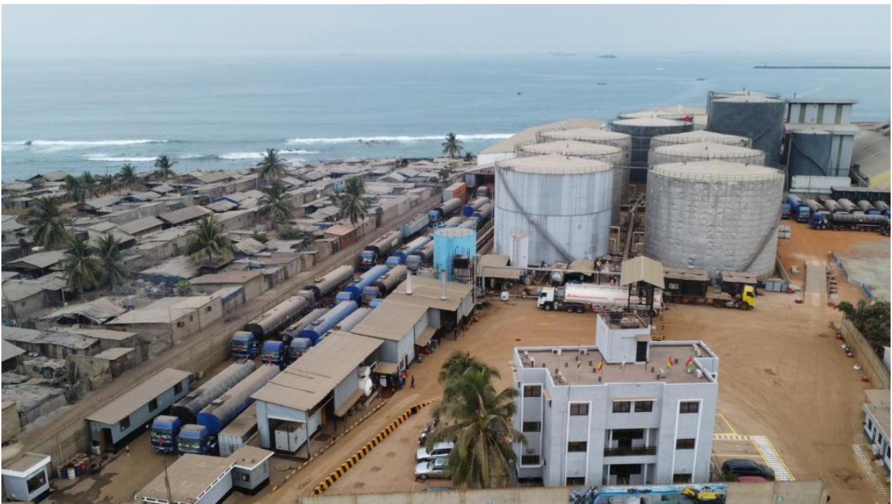
Vue d'ensemble du site d'ERES-TOGO
