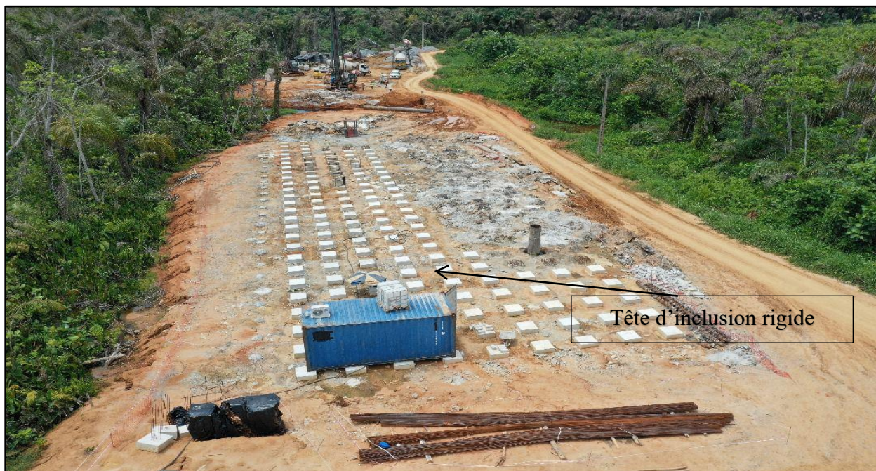
Figure 15: Inclusions rigides mis en œuvre à Adiaké par SOLID (Lennisongui COULIBALY, 2024)
