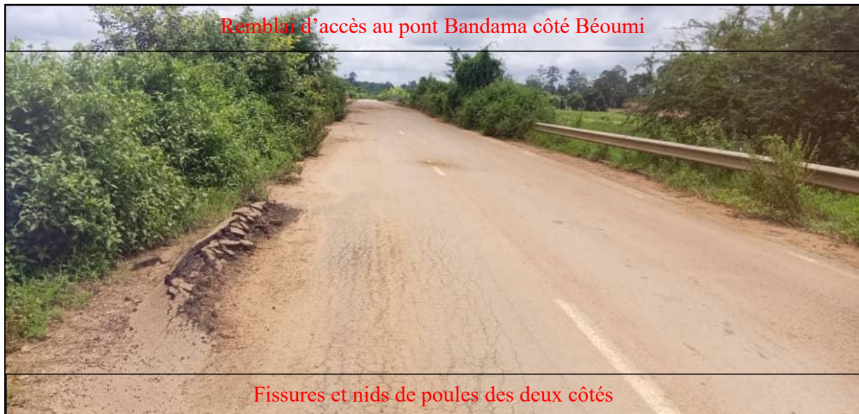
Photo A 2 : Désordres observés au niveau remblai d'accès au pont Bandama côté Béoumi
