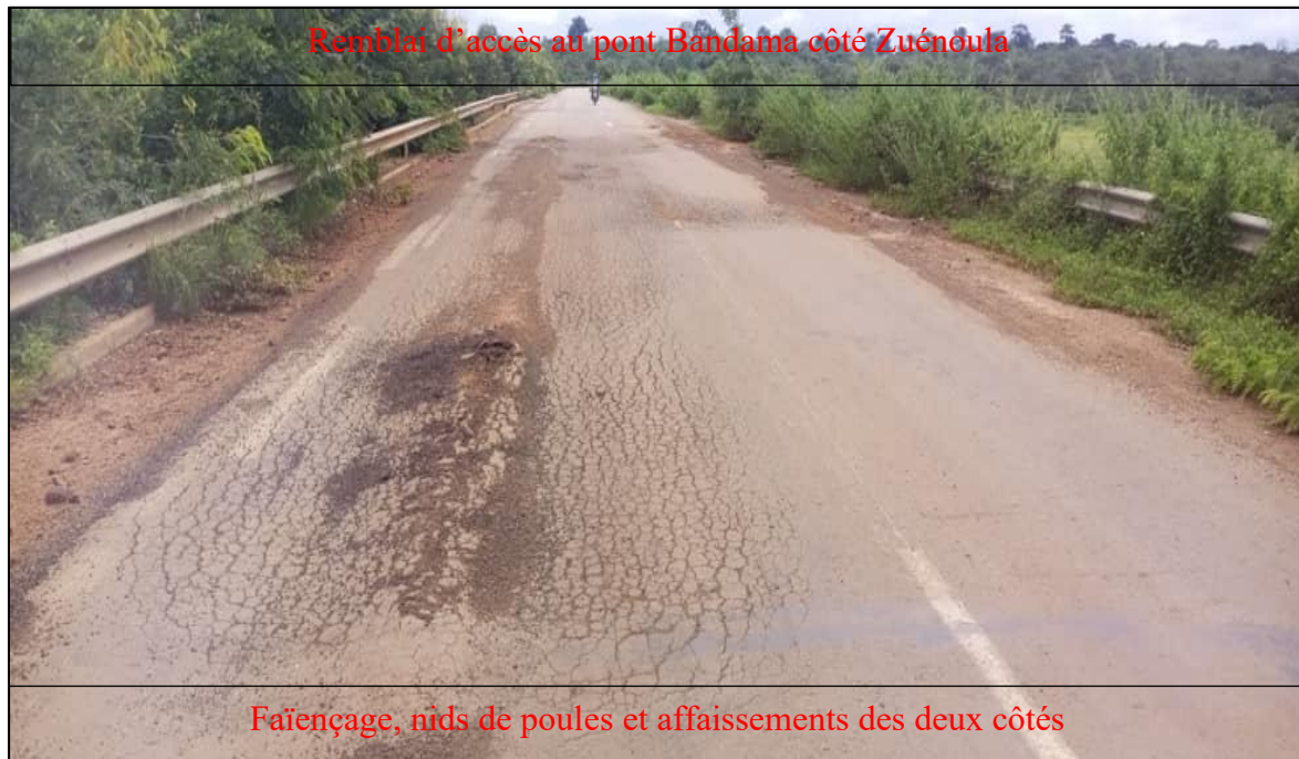
Photo A 3 : Désordres observés au niveau remblai d'accès au pont Bandama côté Zuénoula
