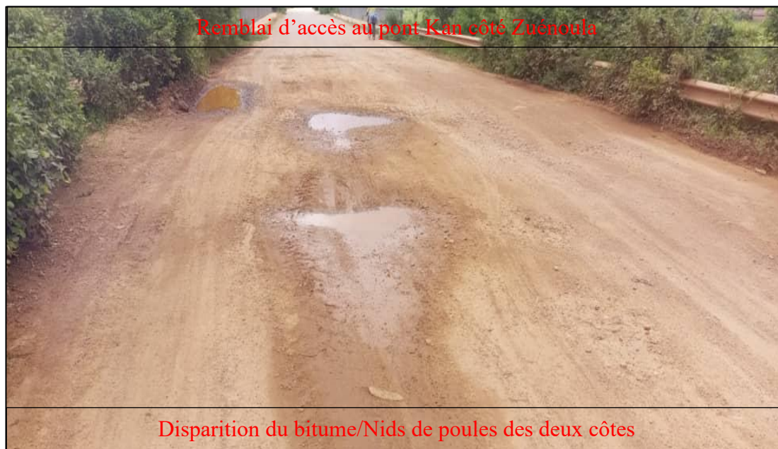
Photo A 1 : Désordres observés au niveau remblai d'accès au pont Kan côté Zuénoula
