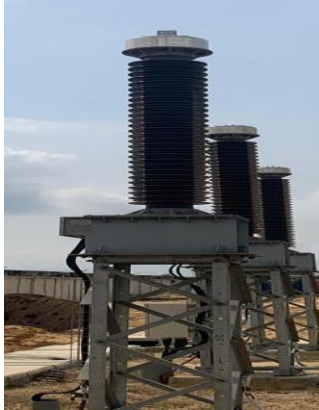
Figure 14: transformateur de tension
