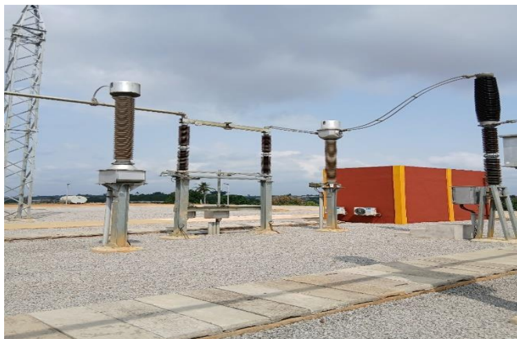
Figure 10: Image d'une travée couplage
