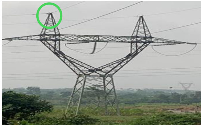
Figure 5: Câble de garde [9].
