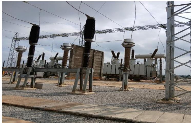
Figure 11: Image d'une travée transformateur
