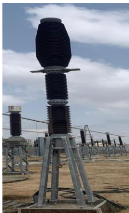
Figure 13: disjoncteur HTB
