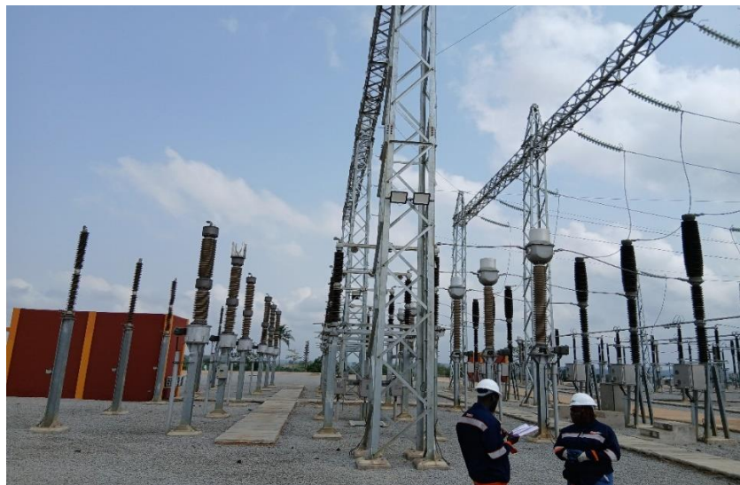
Figure 9 : Image d'une travée ligne
