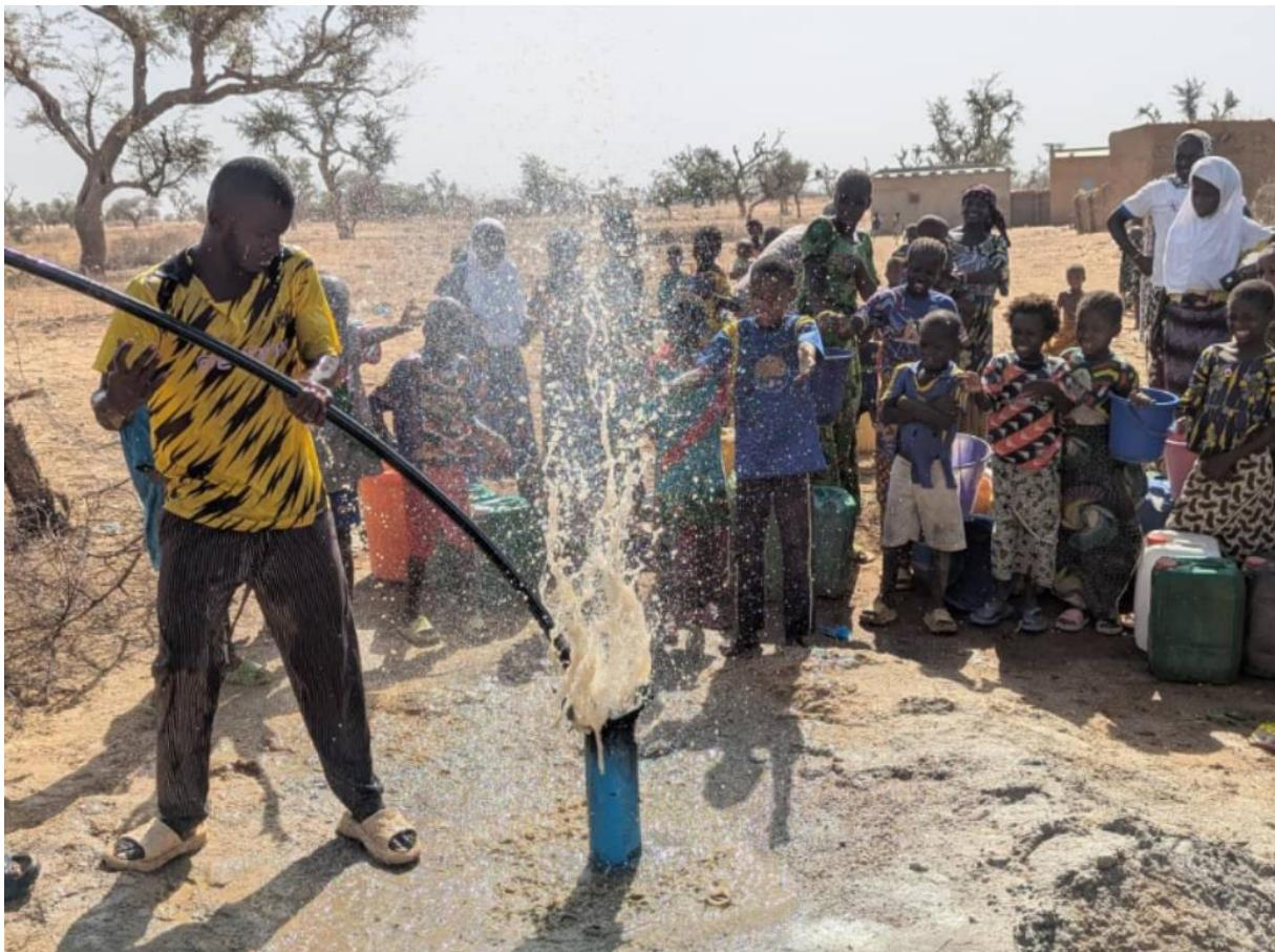
**Figure 15 : Soufflage d'un forage**
