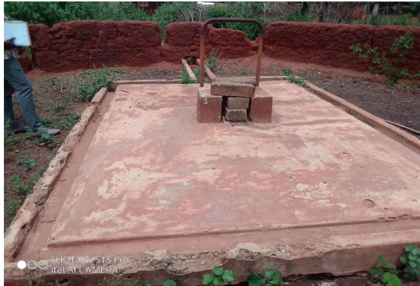
**Figure 18** : Dégradation d'une margelle dans la commune de Kpomassè
