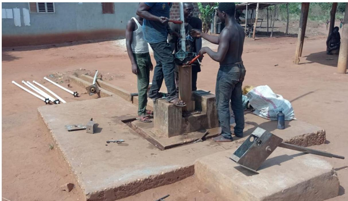
**Figure 14** : Démontage d'une ancienne pompe de type INDIA MARK II
