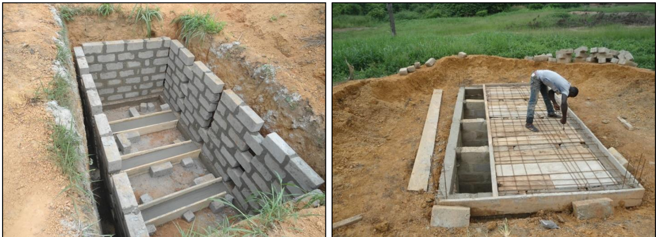
Figure 5 : Construction des latrines
