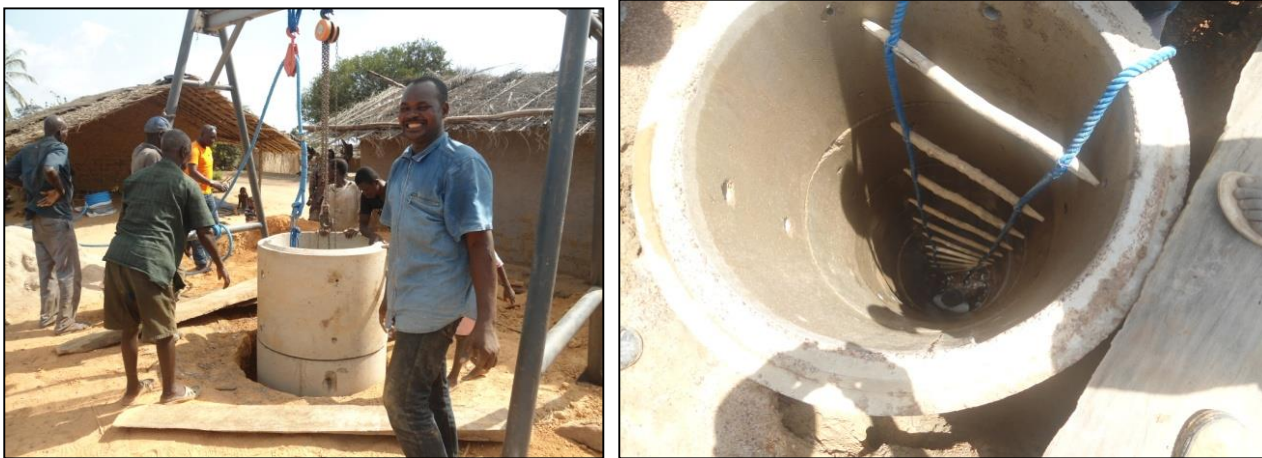
Figure 7: Construction des puits busés
