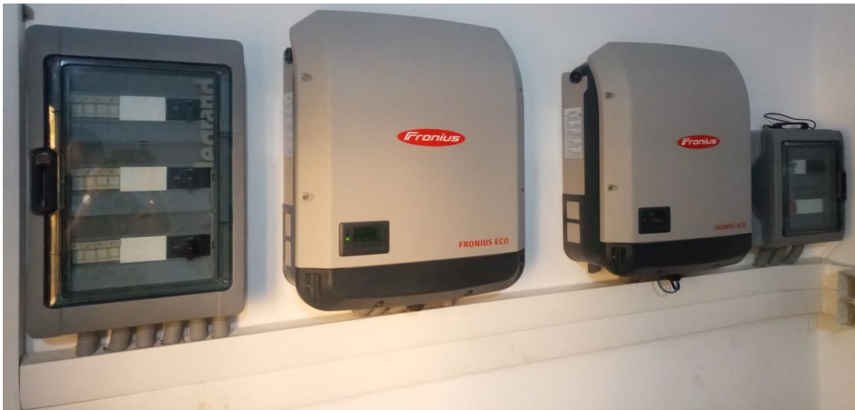
Figure 12: Onduleur PV installés sur site
