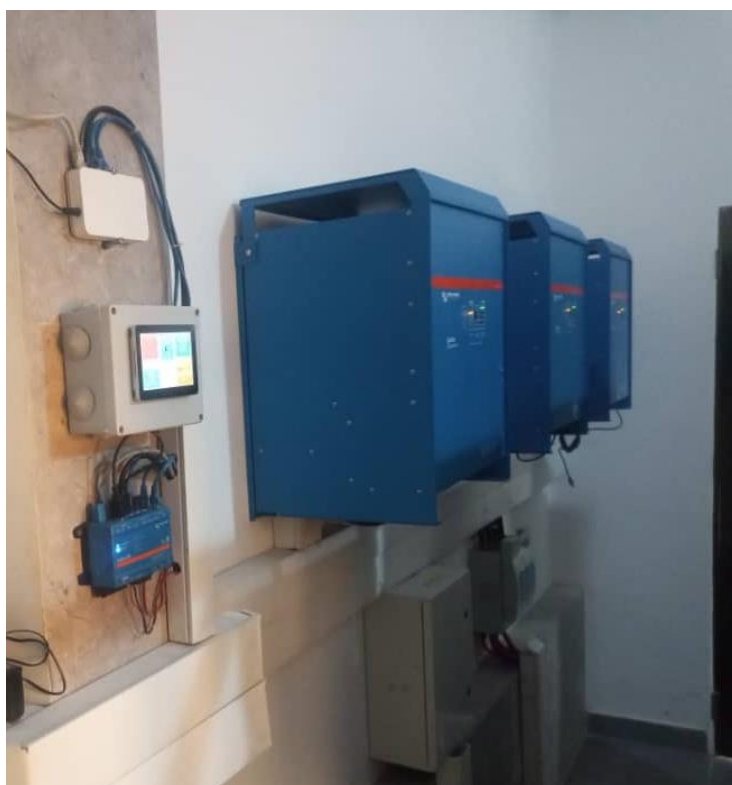
Figure 15: Onduleurs chargeurs 15kVA
