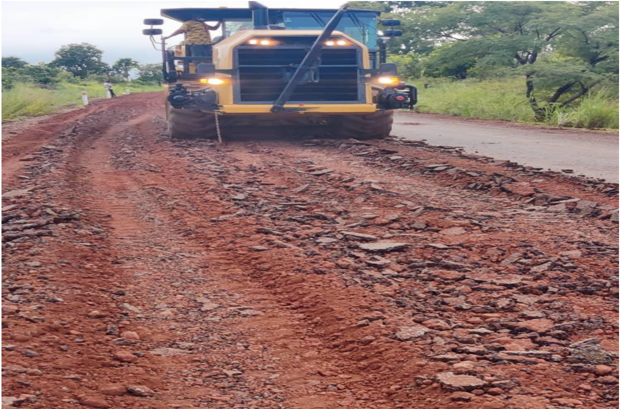
Figure 28: Recyclage de la chaussée existante
