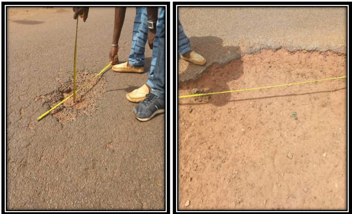
Figure 2: Etat dégradé de la chaussée existante
