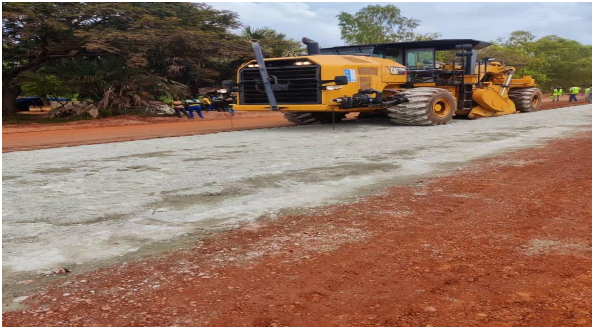
Figure 30: Illustration du malaxage du matériau amélioré
