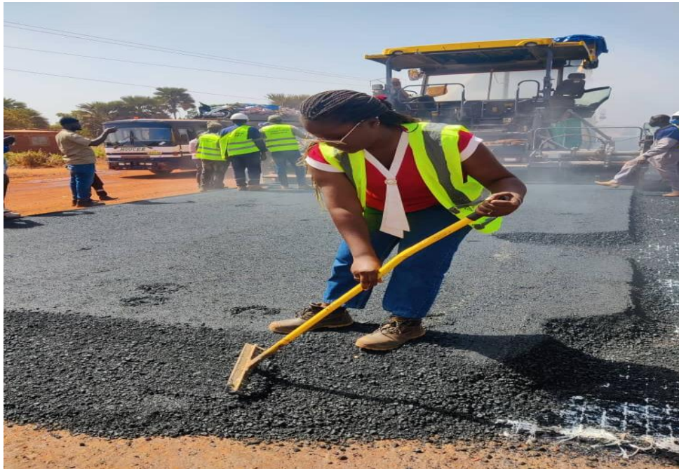
Figure 31: Illustration de la mise en œuvre de la grave-bitume
