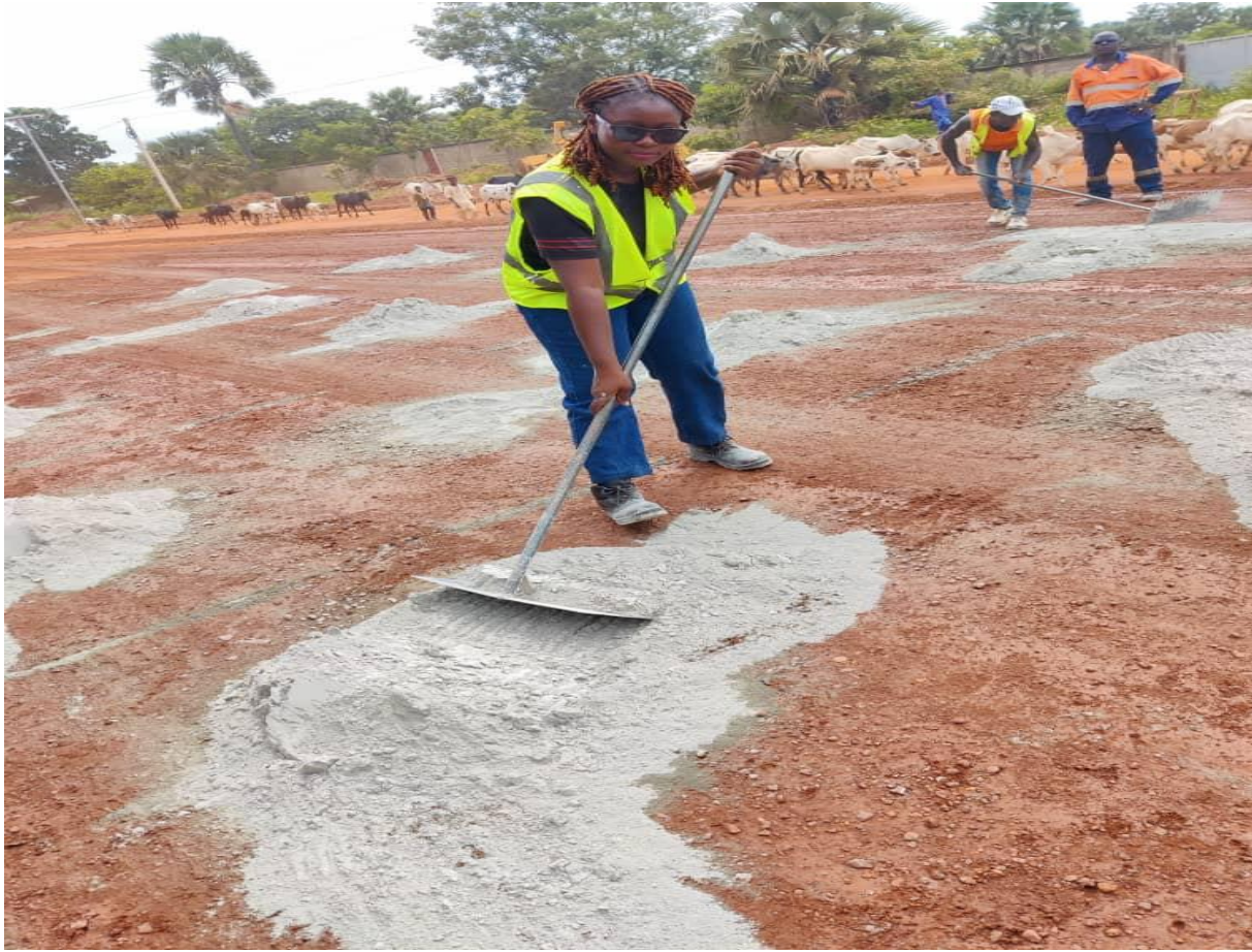
Figure 29: Illustration de l'épandage du ciment par maille
