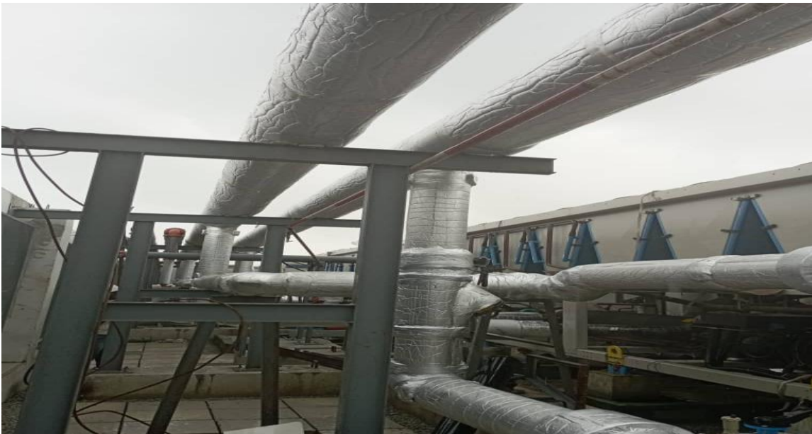
Figure 19:Support métallique recevant les tuyauteries d'eau
