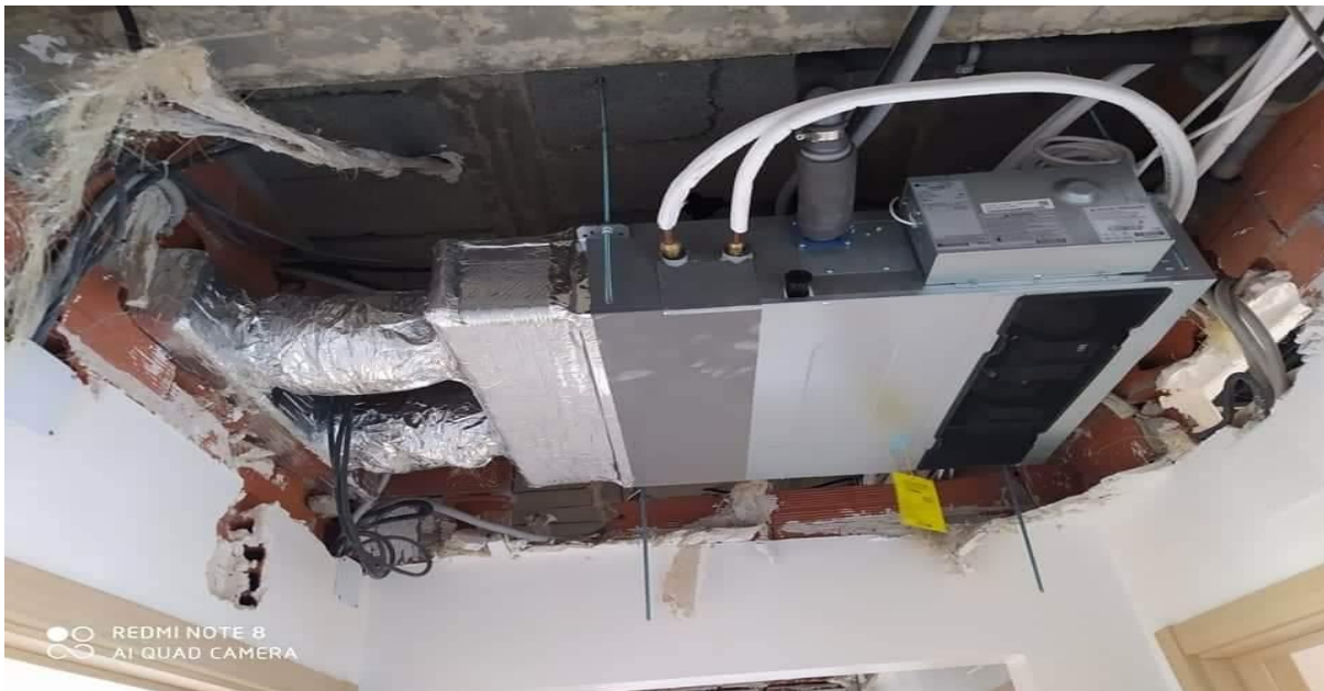
Figure 15: Connexion de ventilo-convecteur avec le plenum box et le réseau d'eau glacée
