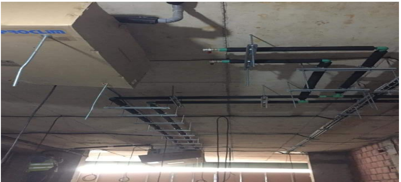
Figure 14:Disposition du ventilo-convecteur et les tuyauteries d'eau glacée
