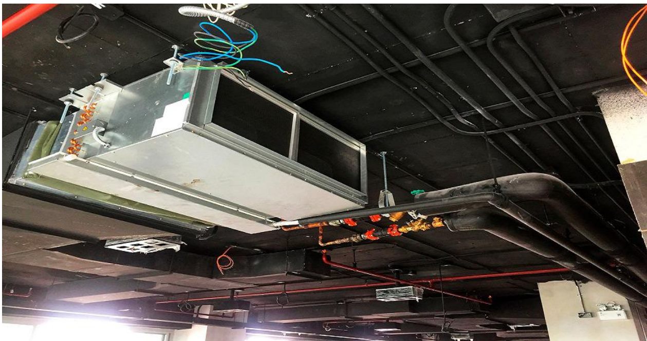
Figure 16:Connexion du picv au ventilo-convecteur
