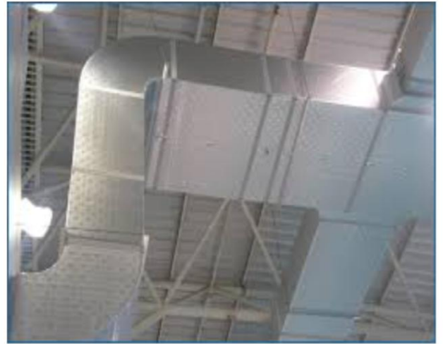
Figure 17:Exemple de montage de gaine en panneaux de polyuréthane
