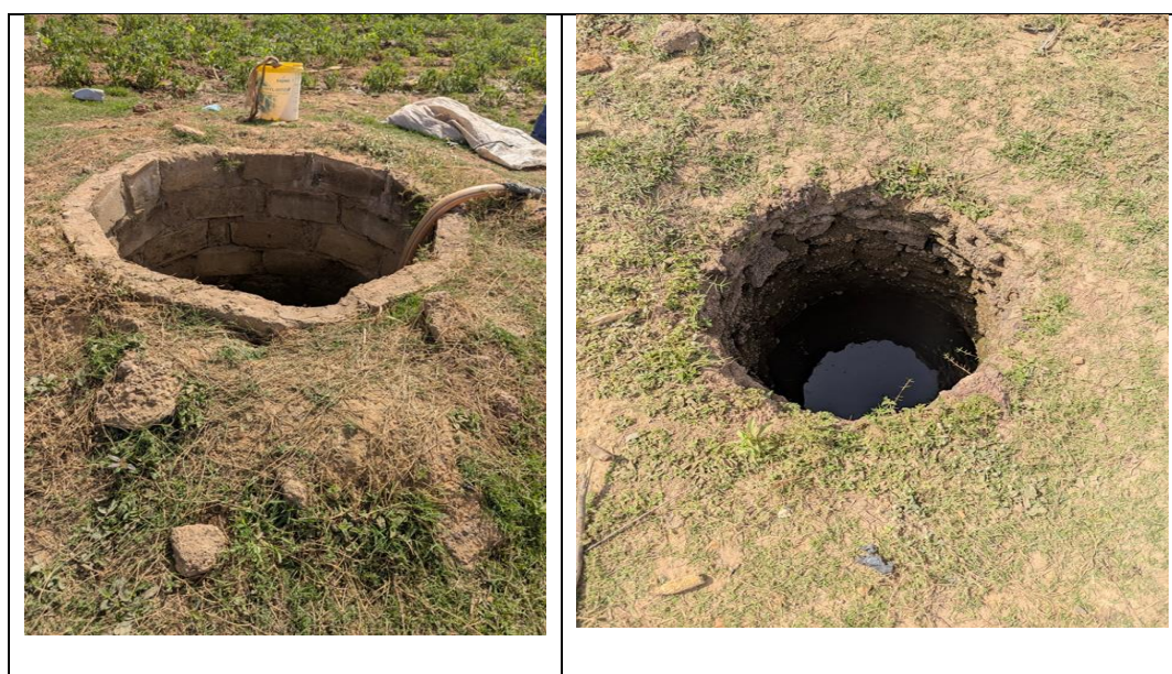
Figure 16 : Photos illustratives de l'état des puits rencontrés
