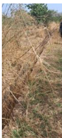
Figure 17 : CP1 à 100% enherbé avec remblai des cavaliers dégradés
