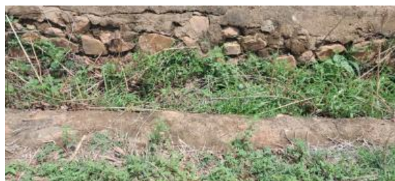
Figure 15 : tête morte dégradée à 100%
