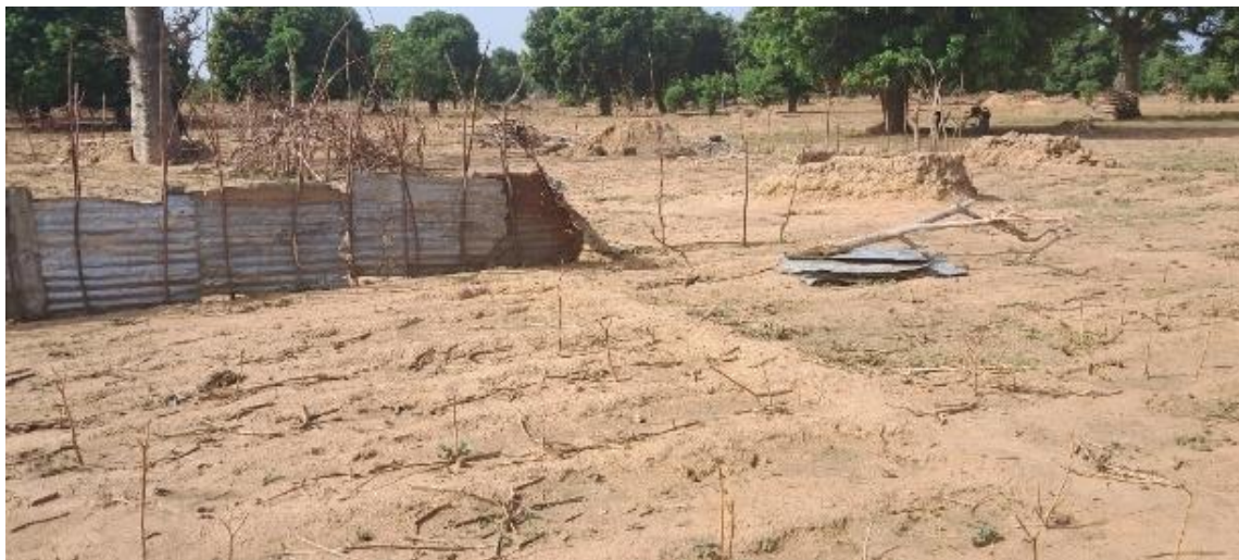
Figure 7: puits à grand diamètre de l'aménagement
