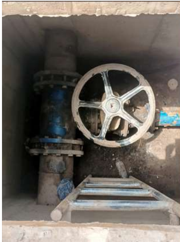
Figure 3: Regard à la sortie de la Bâche de Guilingou
