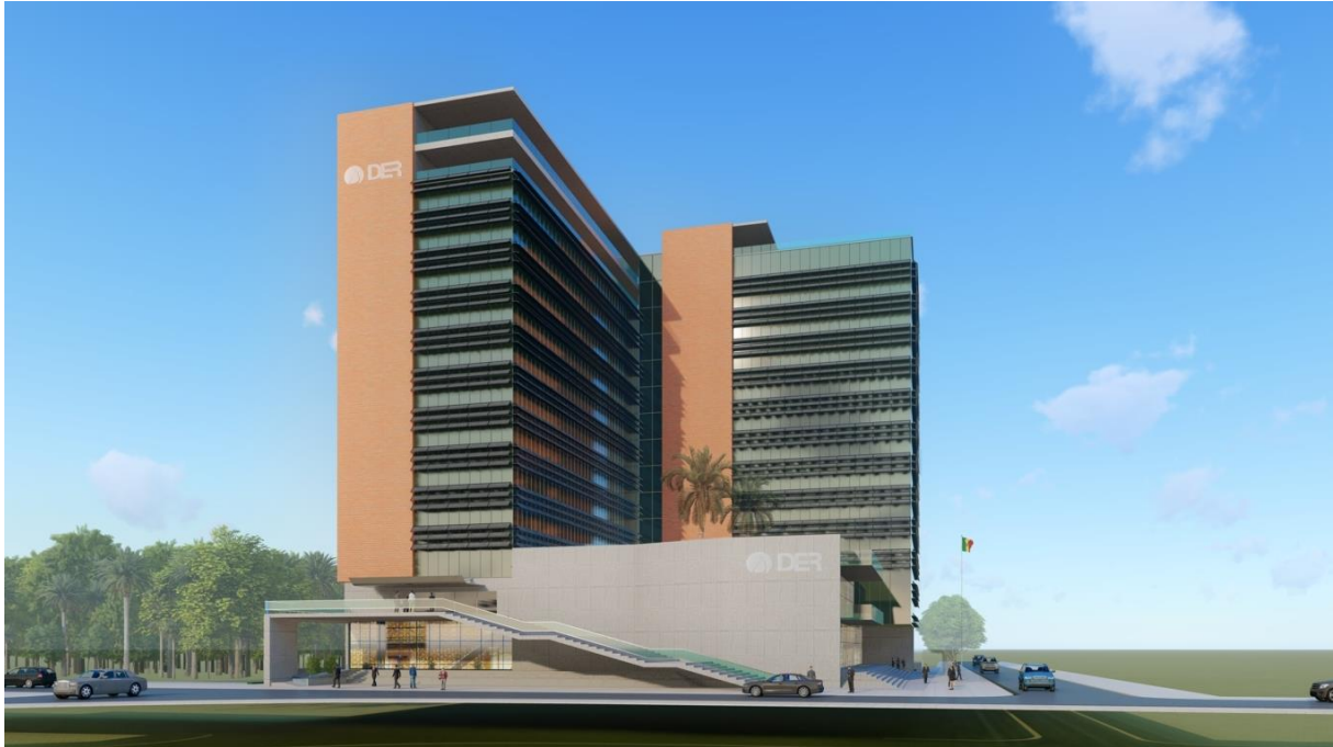
Figure 3 Vue d'ensemble du bâtiment
