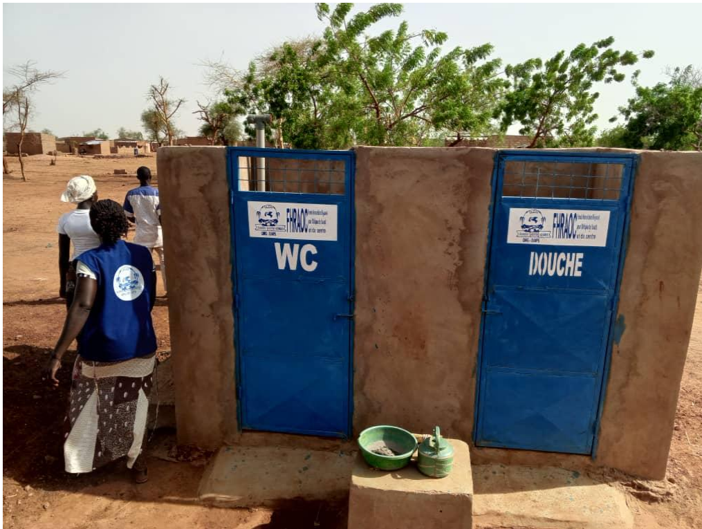
Ouvrage d'assainissement réalisé par APS
