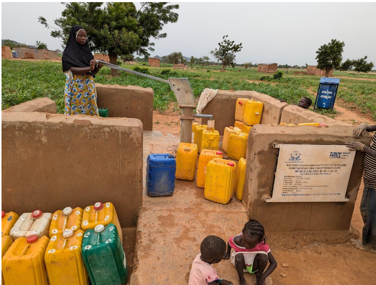
Pompe à motricité humaine réalisée par l'ONG-D/APS au site Lilima
