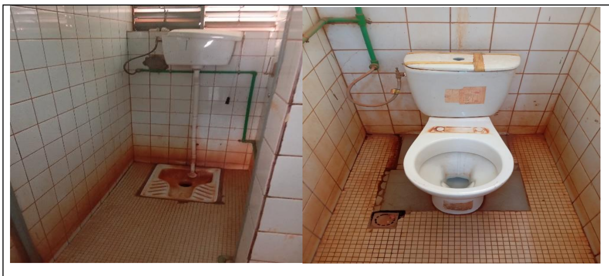
FIGURE 4 : TOILETTES DU PERSONNEL DU BATIMENT 1 (FELICIA, 2024)
