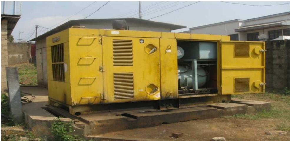
Illustration 8: Groupe électrogène de 220 kVA à la station de repompage R2
