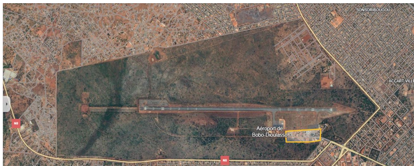
Figure 5 : Vue espace aménagé encerclé en jaune
