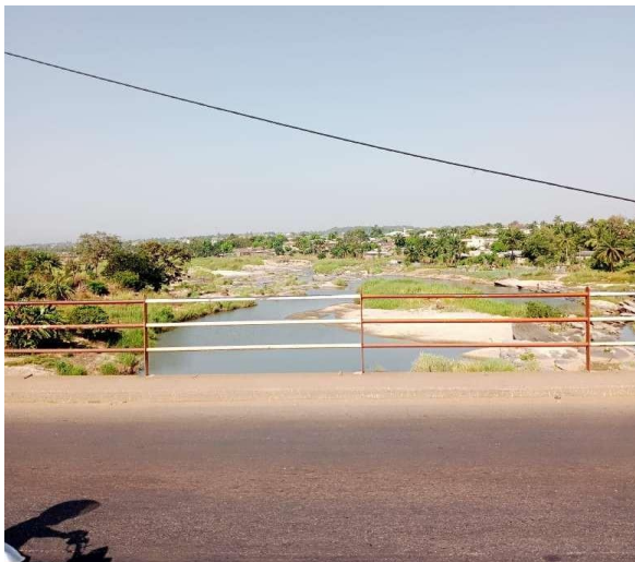
Figure 5 : Garde-corps le long du pont existant
