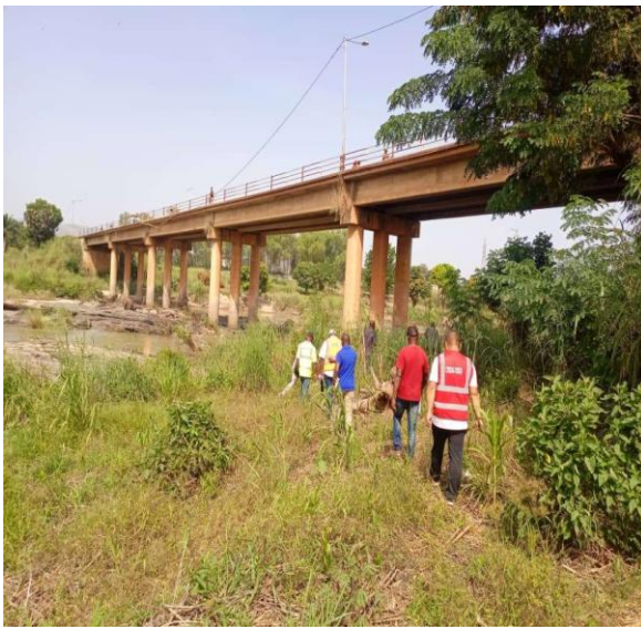
Figure 3 : Aperçu du pont existant
