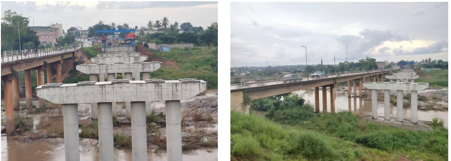
Figure 10 : Etats des travaux en suspend sur le site
