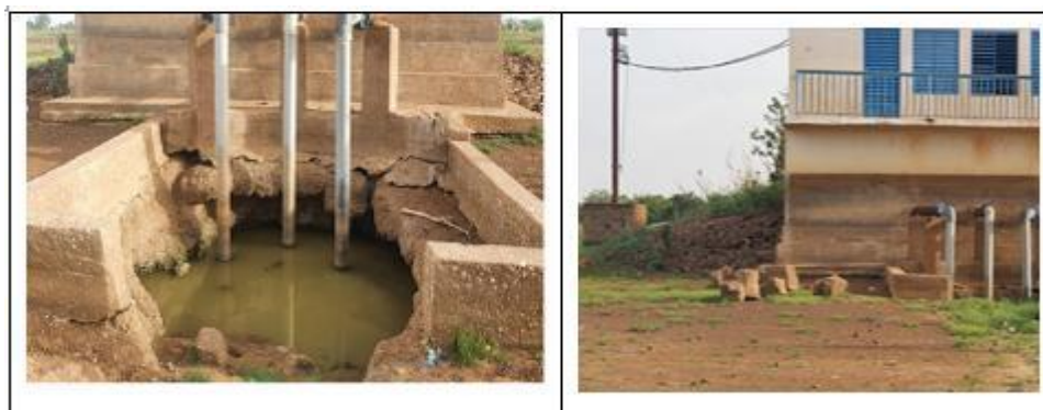
Figure 8 : Vue d'ensemble du puit de pompage
