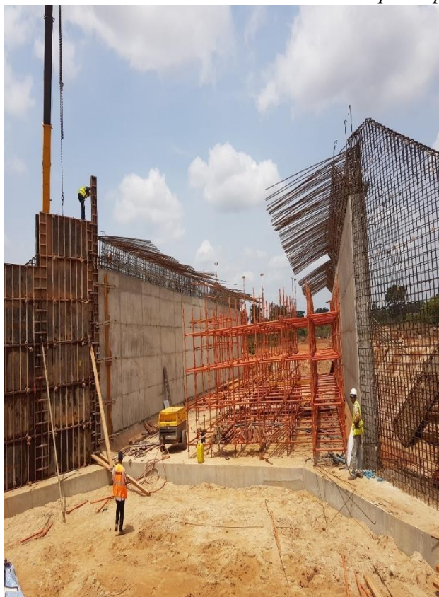
Photo 7 : Coffrage des ailes amont du Passage Inférieur de Tiébissou au PK 29+040
