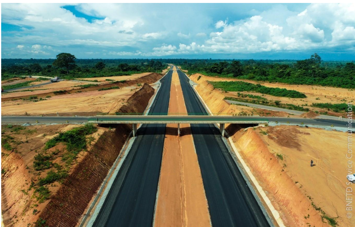
Photo 10 : Vue aérienne de la section autoroutière au niveau du PS de LOLOBO
