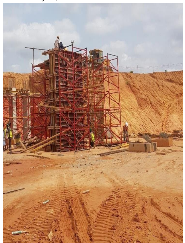
Photo 8 : Coffrage d'une pile du PS de LOLOBO au PK8+320
