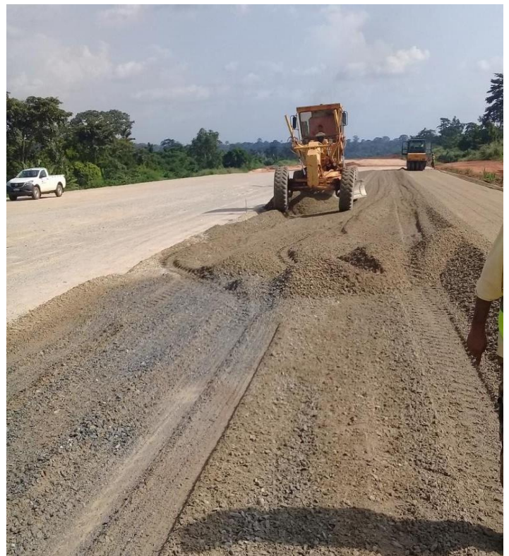
Photo 4 : Mise en œuvre du TVC 0/60
