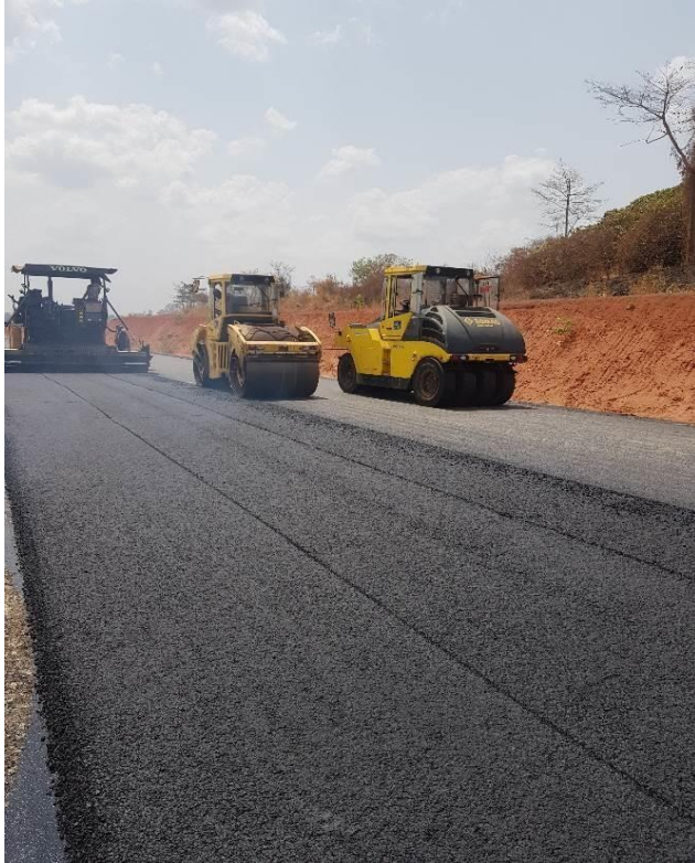
Photos 5 et 6 : Mise en œuvre de la couche de liaison entre le PK11 et le PK12
