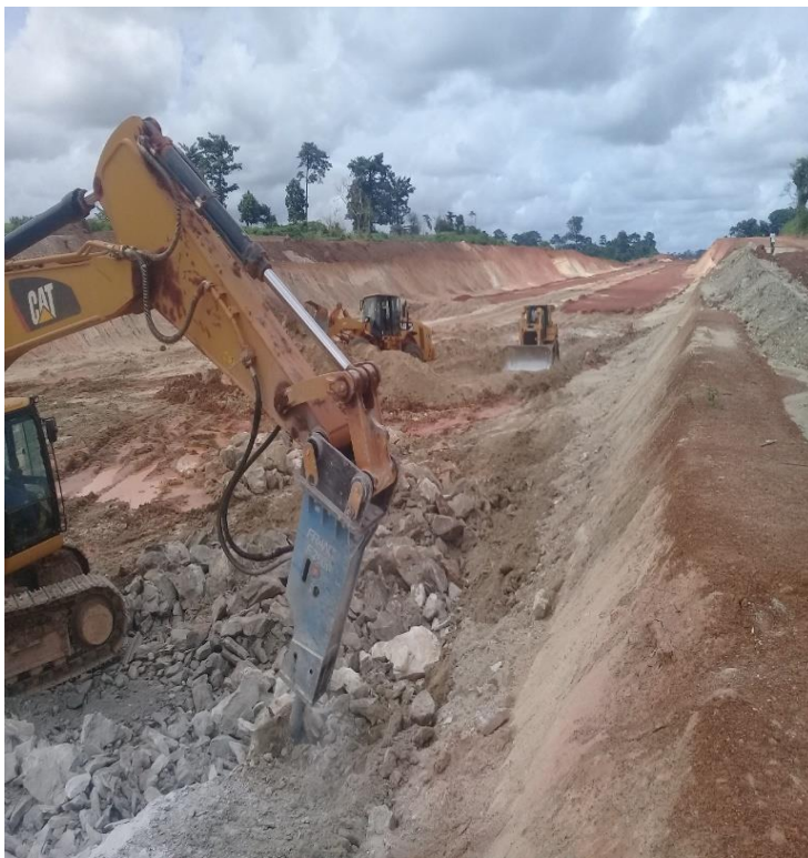
Photo 3 : Déroctage de blocs rocheux compacts dans le Déblai 12 entre le PK15+458 et le PK15+572
