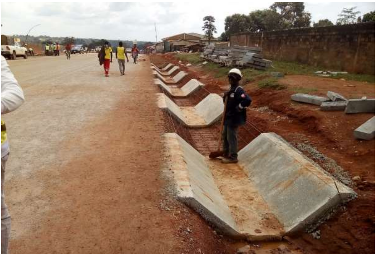
Phase d'exécution du système de drainage à l'entrée de Baoro
