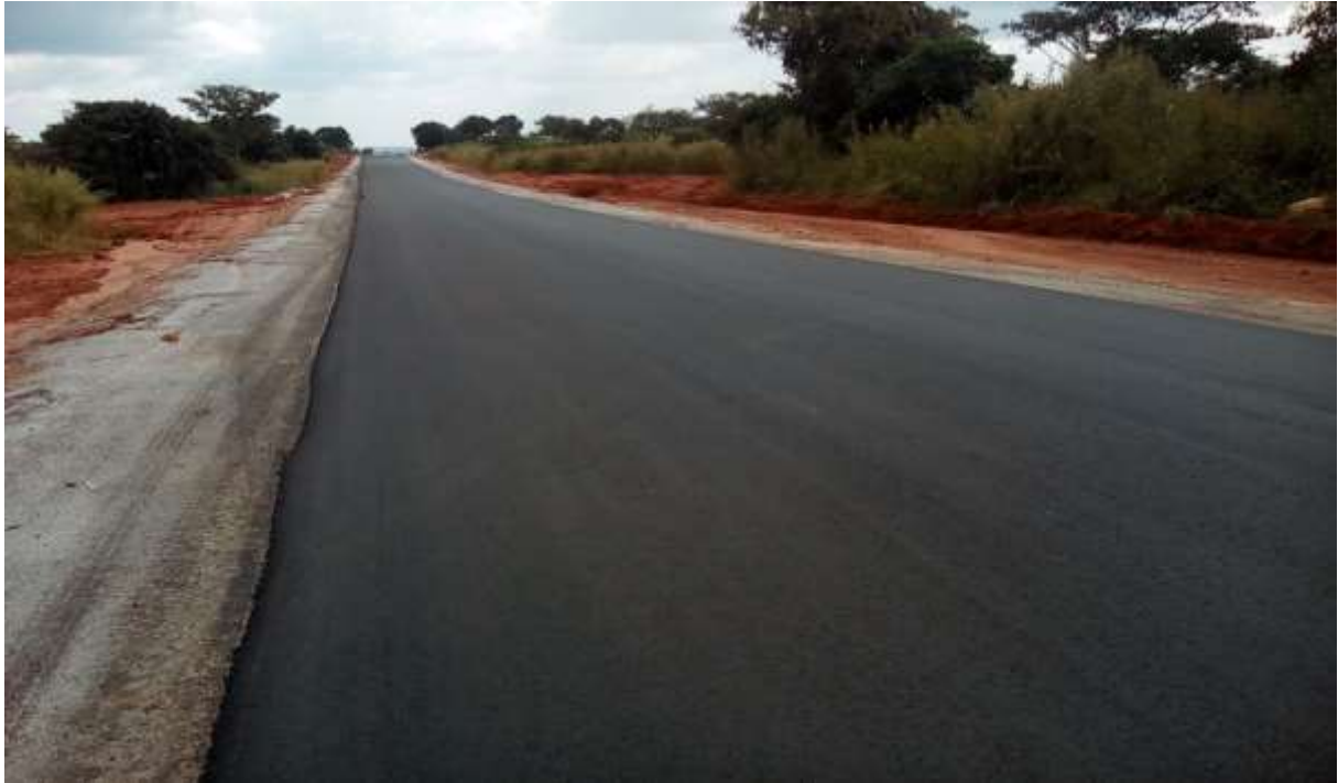
Couche de Roulement après exécution
