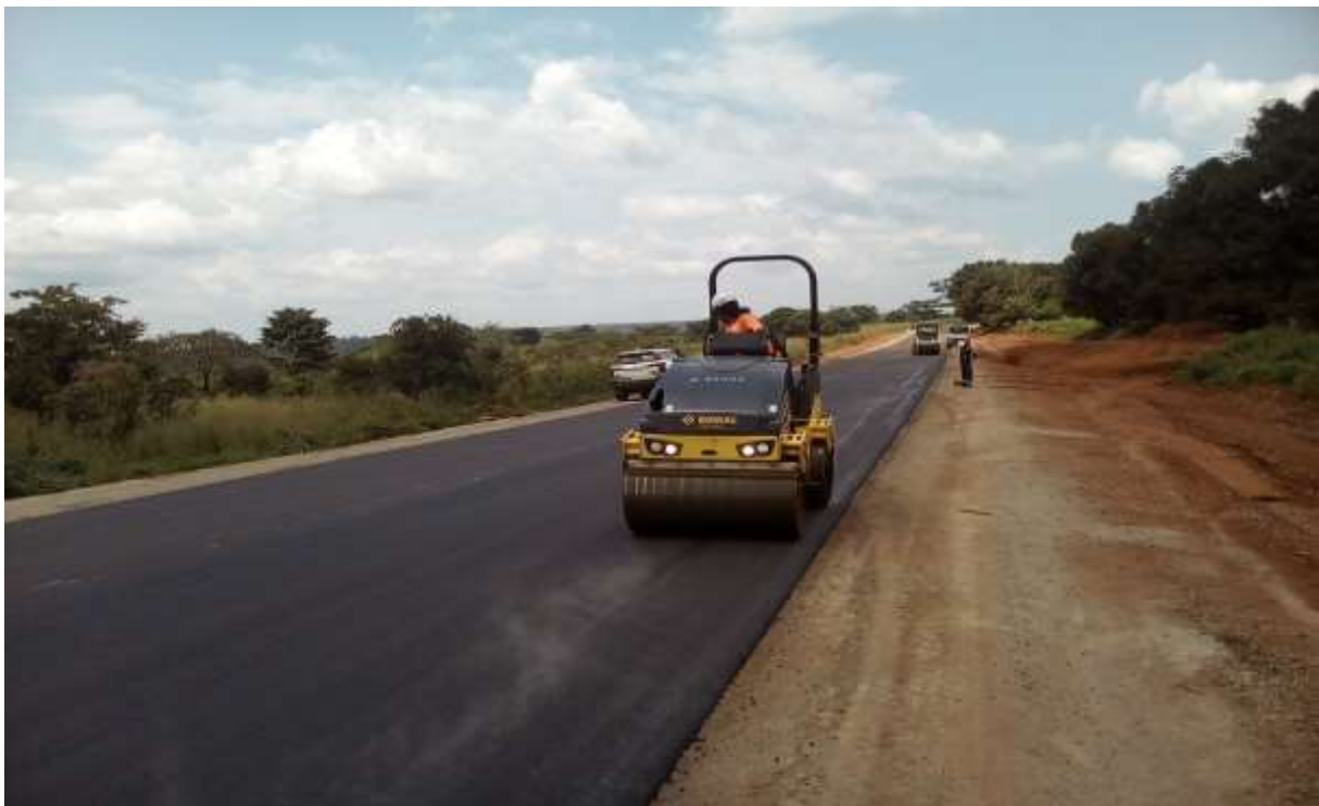
Compactage de la Couche de Roulement par une Femme Conducteur
