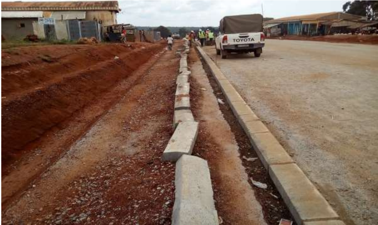
Pose des bordurettes à l'entrée de la ville de Baoro
