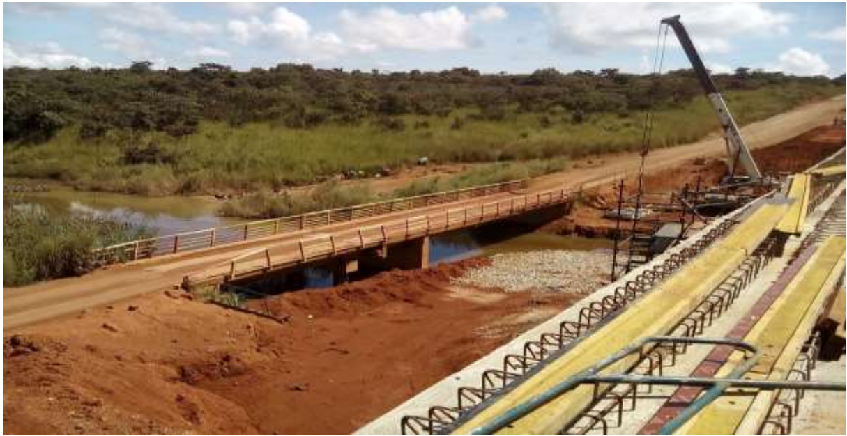
L'ancien et le nouveau Pont « WEN » en construction
