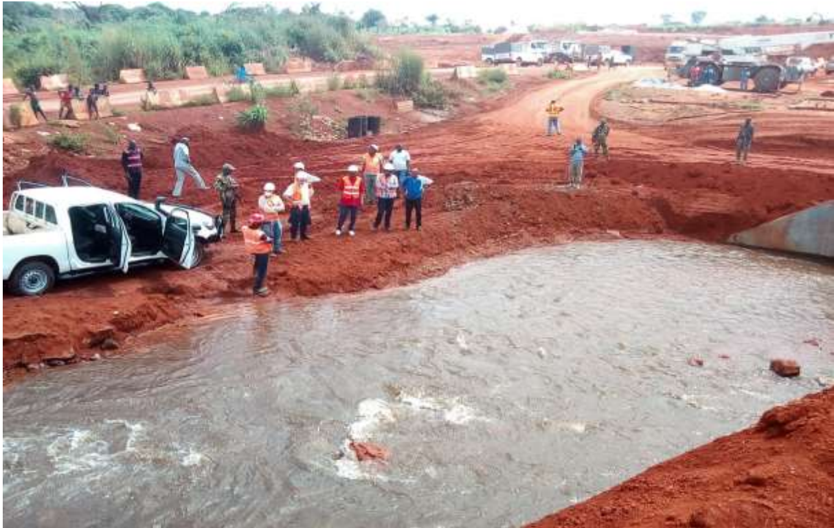
Visite de chantier par Monsieur le Ministre des Travaux Publics
