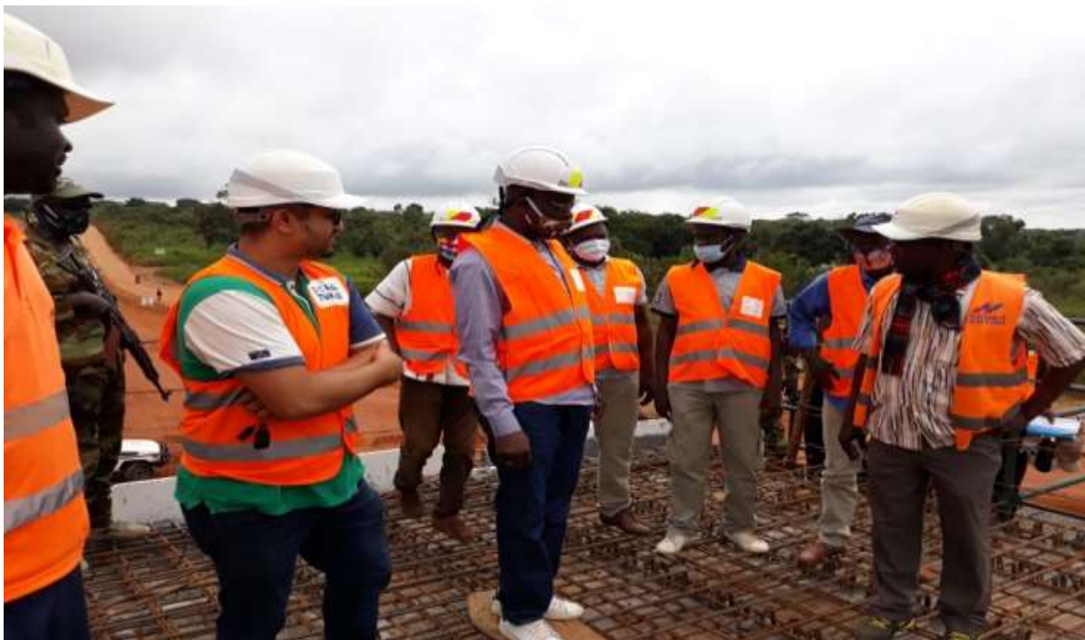
Visite de chantier par Monsieur le Ministre des Travaux Publics
