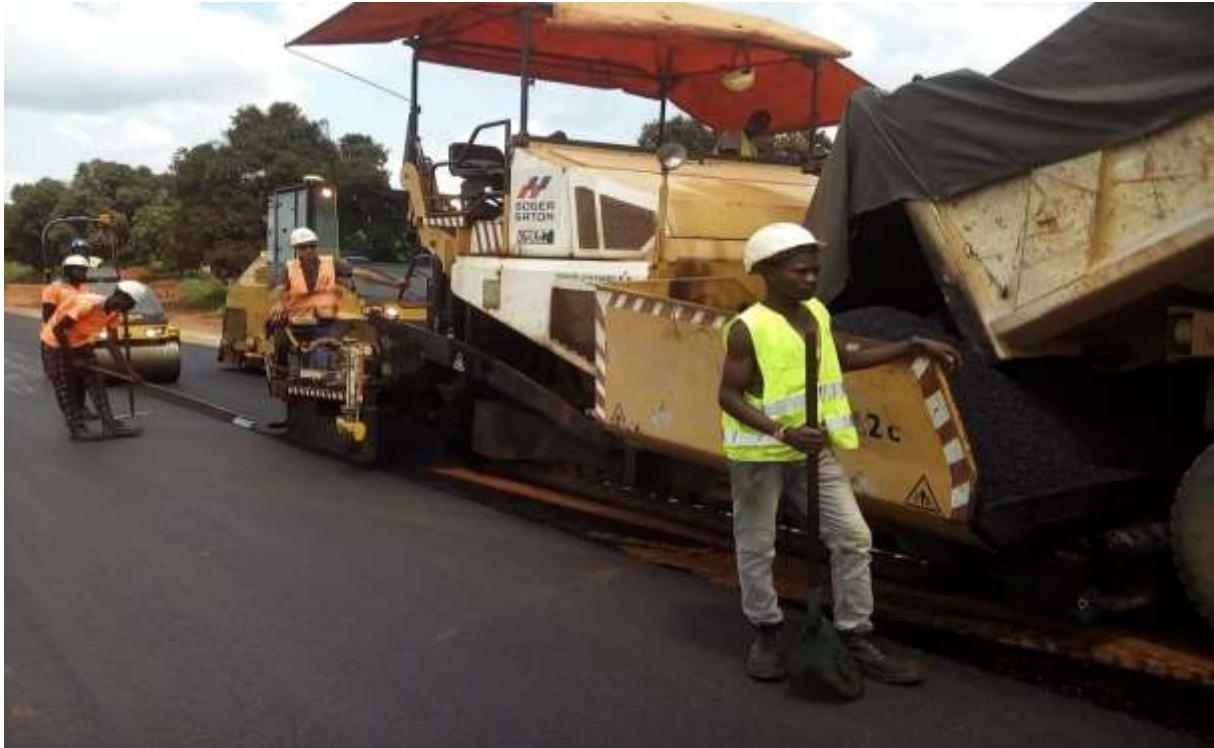
Mise en oeuvre de la Couche de Roulement en BB de 6 cm d'épaisseur
