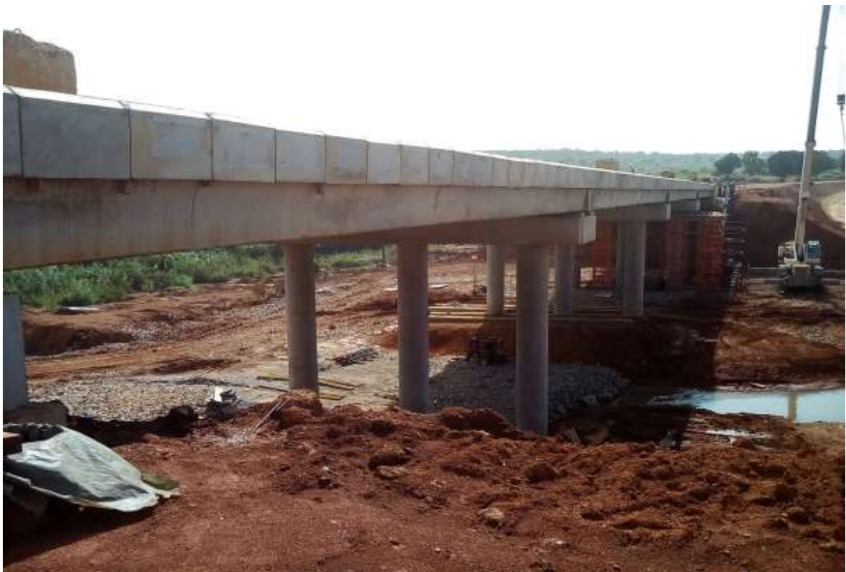
Les culées et le tablier du Pont « WEN » en construction
