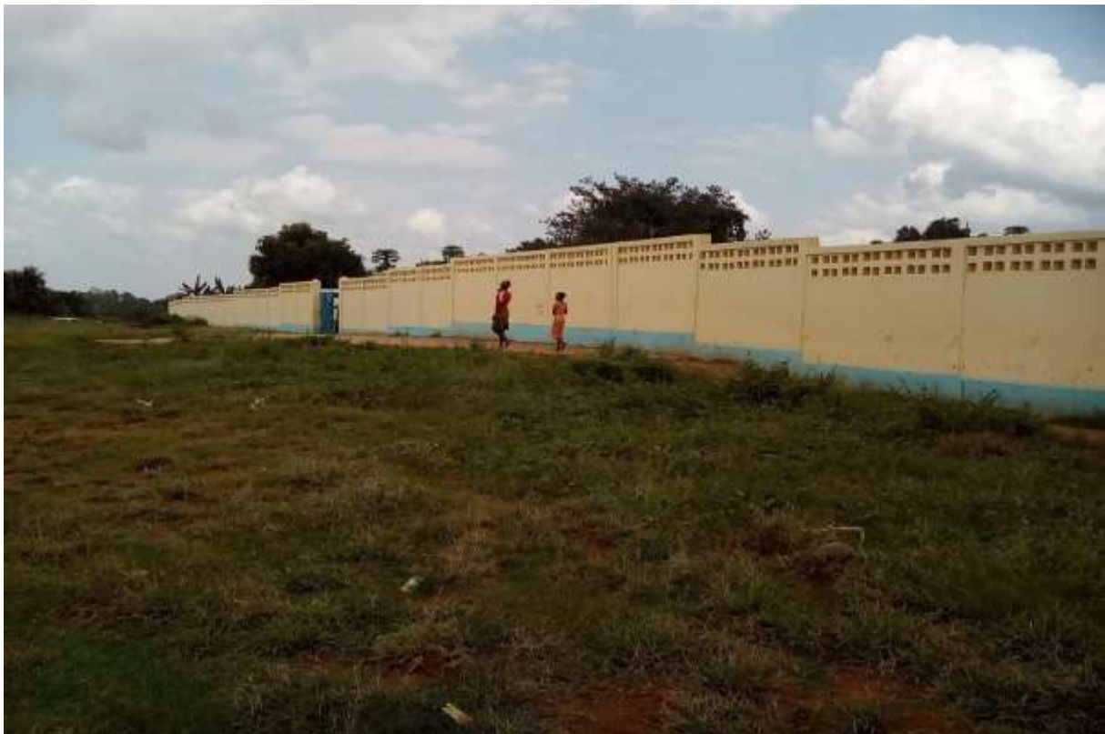
Cloture après travaux de l'Ecole de la Ville de Baoro
