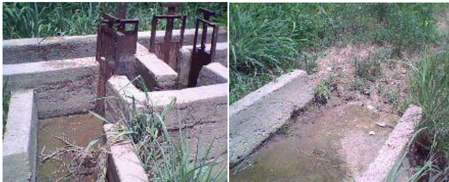
Photo 1: Canaux en état de vétusté sur le périmètre maraîcher de Boussouma
