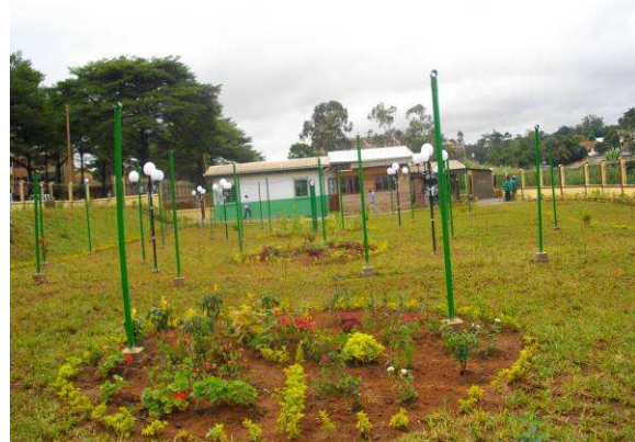
Vue d'ensemble de la station d'épuration
