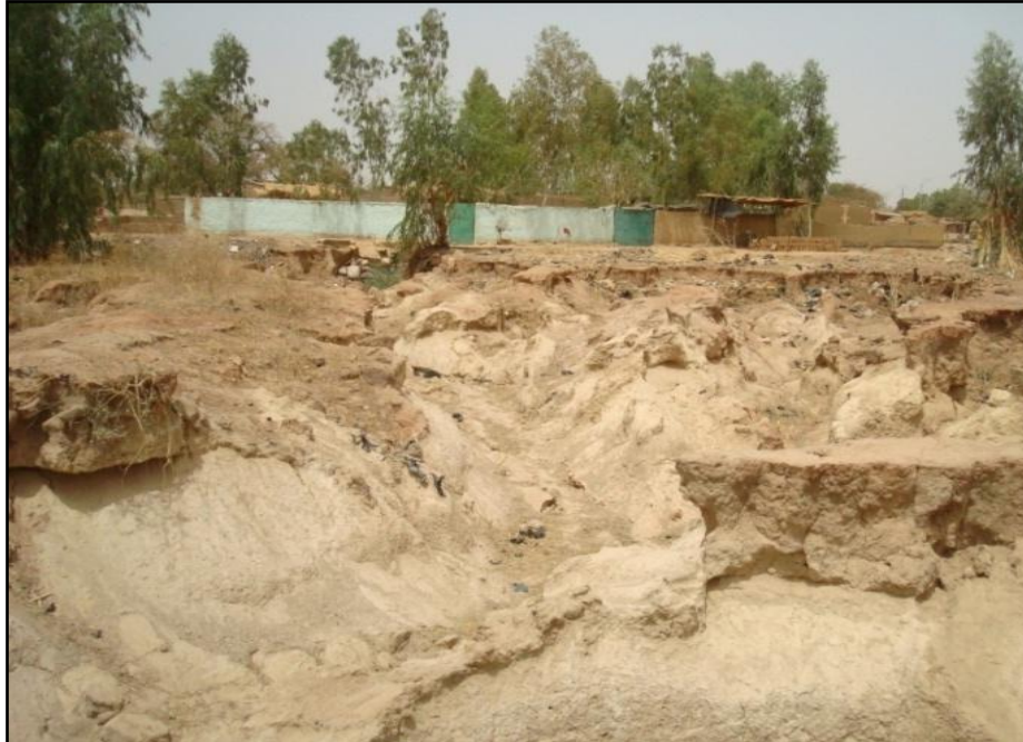
Photo5 : Erosion hydrique à NiokoII
