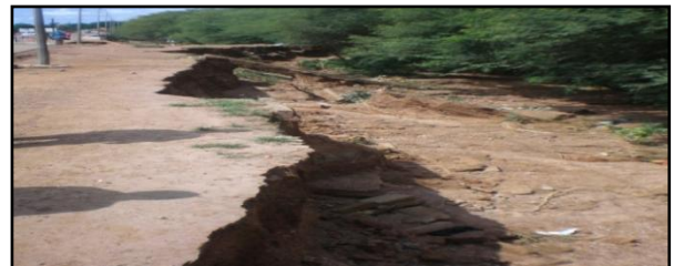
Photo 4: Déversoir du barrage n° 3
