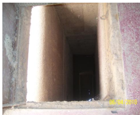
Photo 5 : La chambre bétonnée
