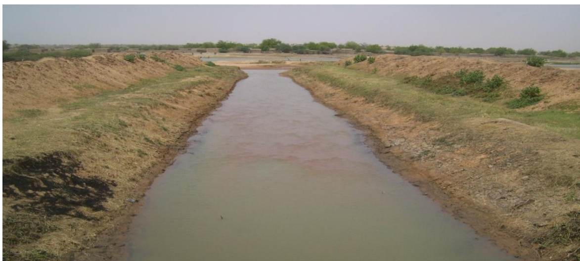
Photo 2 : Chenal d'amenée ensablé (on voit au loin un banc de sable)
