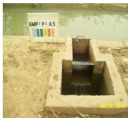
Photo 1 : Matérialisation du tour d'eau
