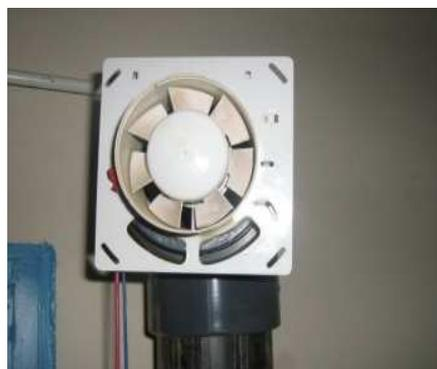
***Figure 6:*** *Ventilateur de soufflage*
