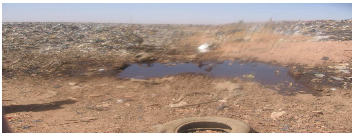
Figure 6: Coulage de lixiviat sur les digues
