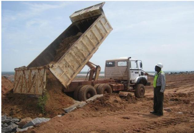
**Photo 7** : Recouvrement des stériles, mine d'or de Morila (S. ILBOUDO, 2011)
