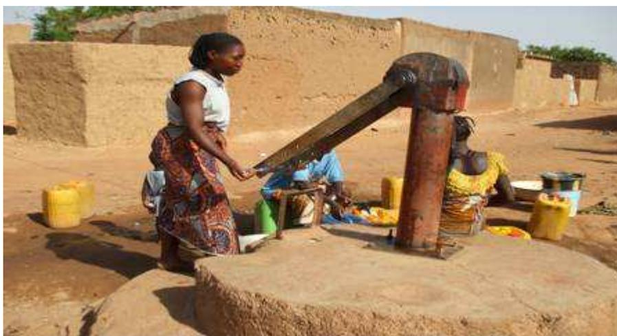
**Photo 4 : Vue d'un forage équipé d'une pompe à motricité humaine**
