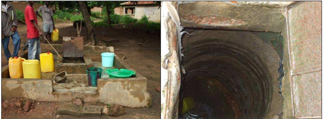
Figure 55 : Photos de a) margelle d'un puits amélioré (à gauche) et b) colonne de puits amélioré (à droite)
