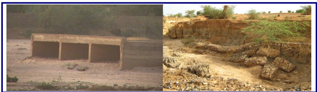
**Photo 2** : Cas de déstabilisation d'un pont à gauche (côté Rive droite) et de destruction nette d'un gabionnage à droite (côté Rive Gauche). (Source : Cissé ; 2009).
