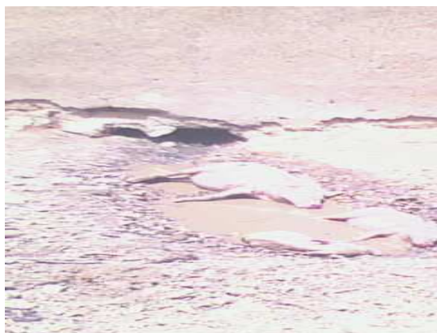
Photo N°8 orifice d'une douche utilisée par les porcs.
