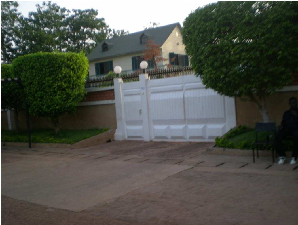
Figure 7: Maison à la Cité de la Zone du Bois
