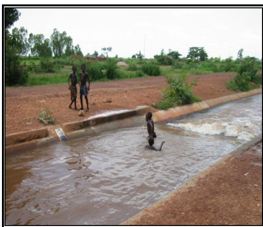
Canal d'amenée du périmètre rizicole
