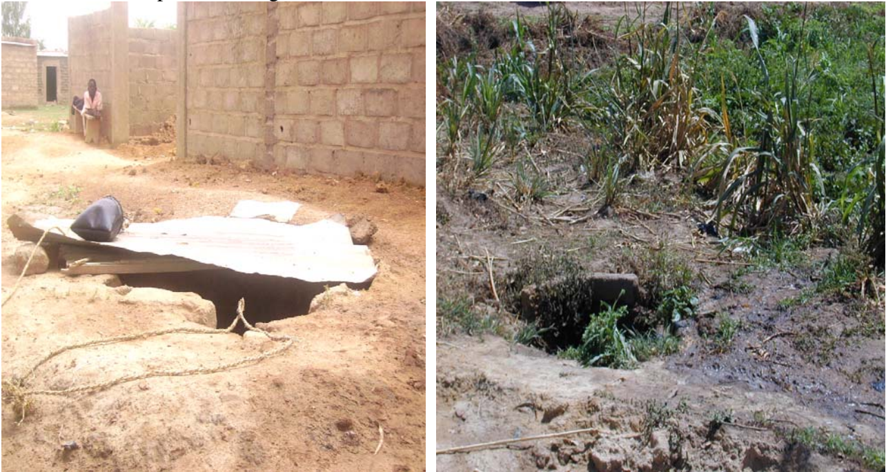
Photo 22: Puits des ménages sans margelles et des maraichers à même le sol
