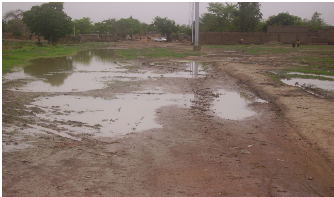
Photo 6: Flaques d'eaux pluviales du secteur 17
