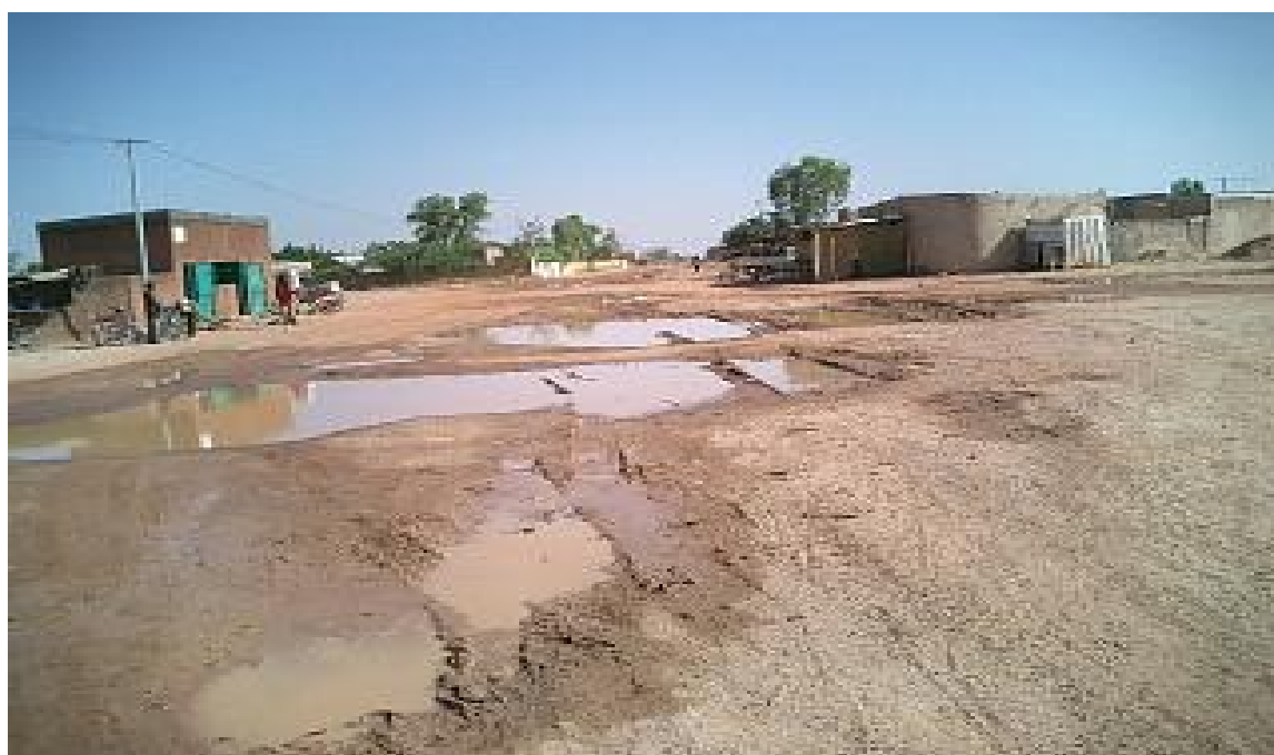
Photo 7: Flaques d'eaux pluviales du secteur 30
