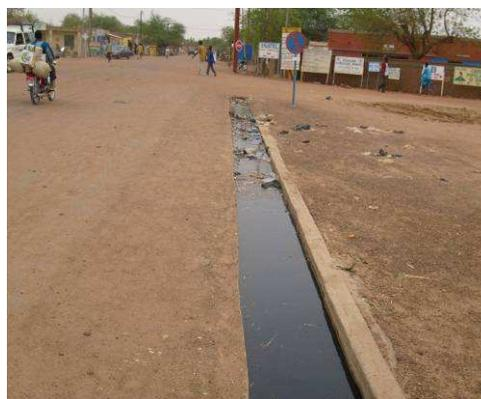
Photo 8 Etat d'un caniveau non fonctionnel
