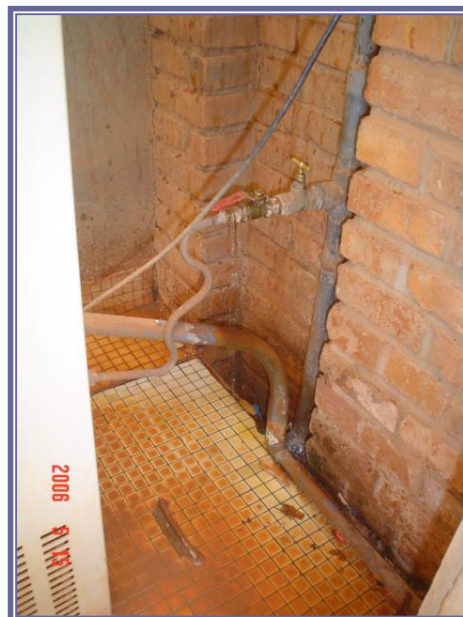
Photo 2 : Fuites sur robinet d'arrosage sur borne fontaine à eau fraîche
