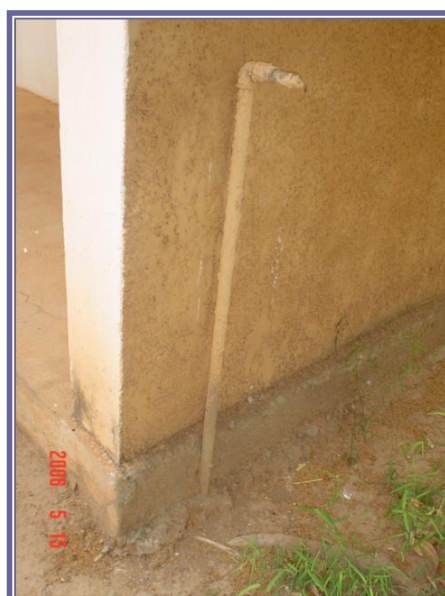
Photo 3 : Robinets d'arrosage non fonctionnels
