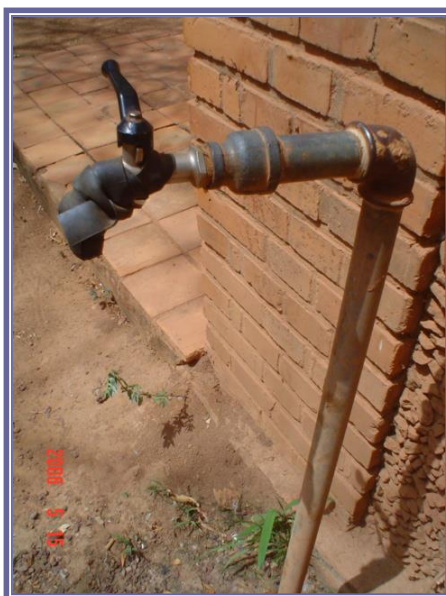
Photo 3 : Robinets d'arrosage non fonctionnels
