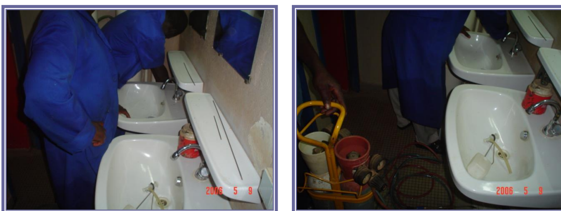
Photo 4 : Intervention sur les conduites du réseau intérieur
