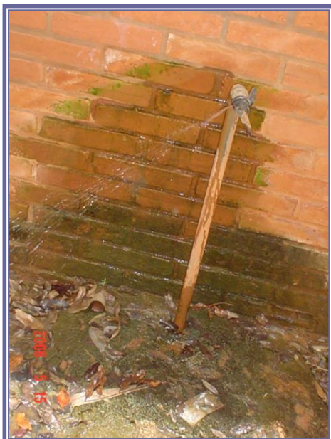
Photo 2 : Fuites sur robinet d'arrosage sur borne fontaine à eau fraîche
