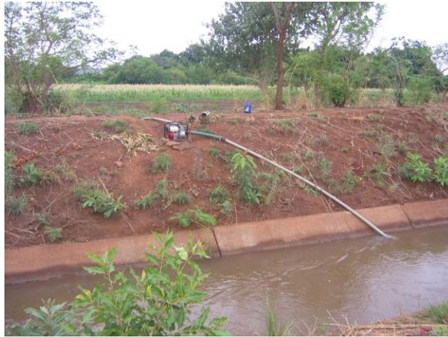
Photo 4 : moto pompe actionnée sur le canal d'amenée
