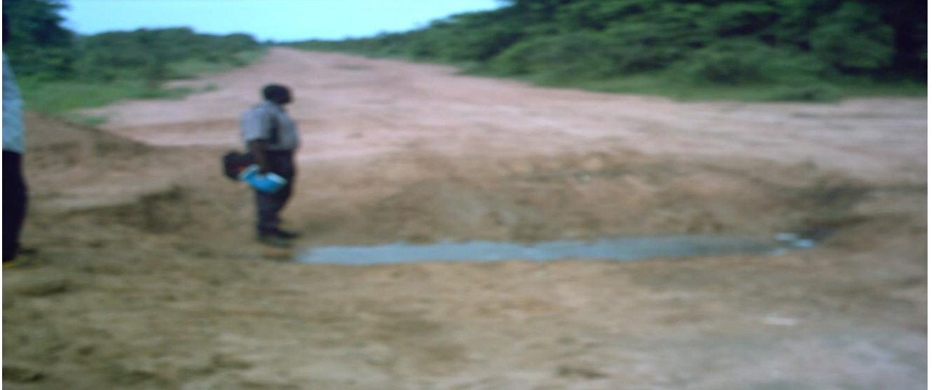
Photo 3 : Zone nécessitant une buse
