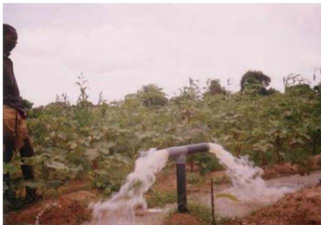
*Photo 6: Borne californienne en fonctionnement*
