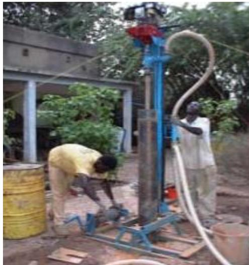
*Photo 3: Réalisation d'un forage à la tarière motorisée*
