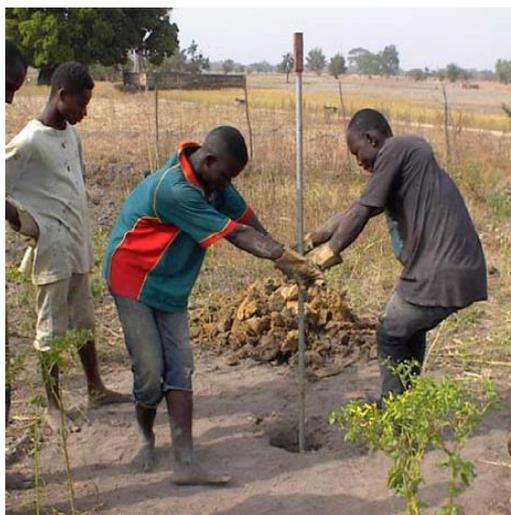
*Photo 2: Réalisation d'un forage à la tarière manuelle*
