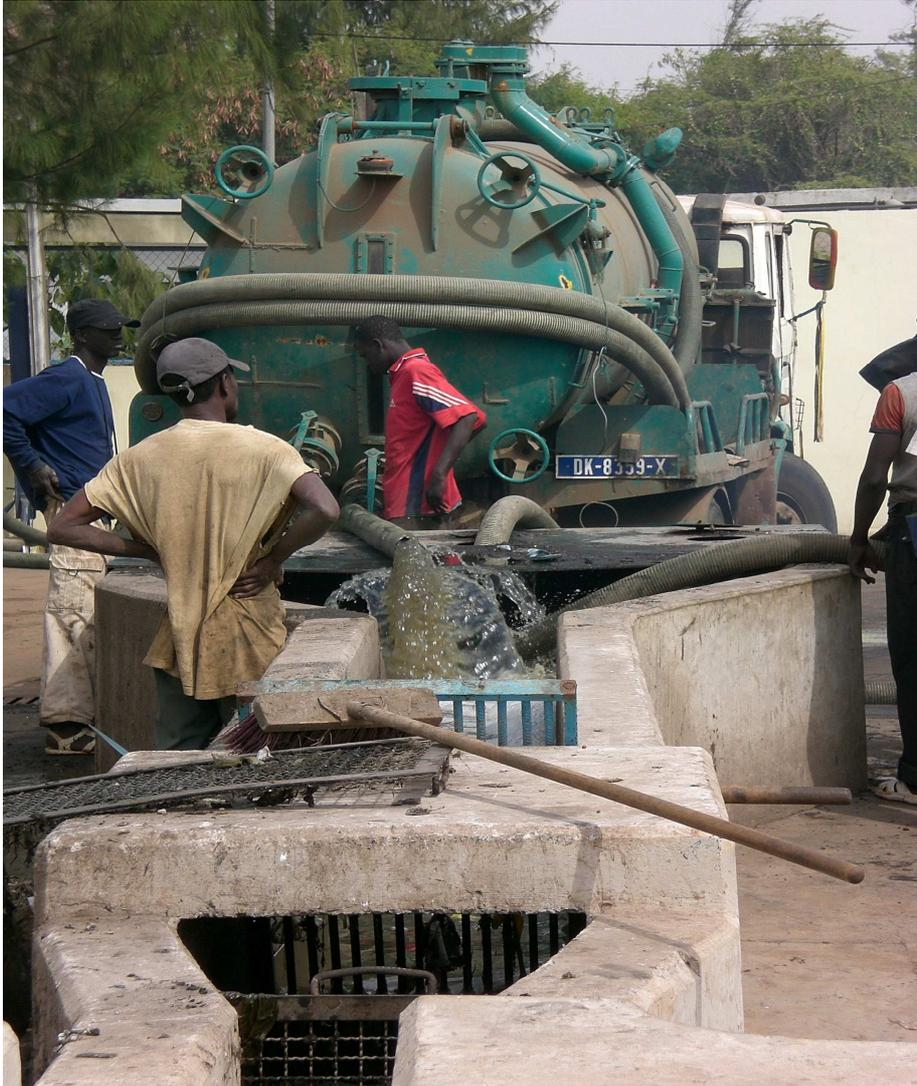
C'est un système de dégrillage manuel composé de deux grilles métalliques posées à travers le canal, l'une devant, d'espacement de 25mm sert à retenir les objets grossiers ; et l'autre derrière, de 20mm d'espacement sert à retenir les objets comme les algues ou les objets qui ont traversé la première grille.
